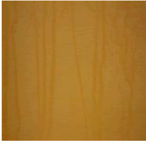
Figura 9: Manchas causadas por pingos isolados de chuva Fonte: empresa de tintas Real (2011)
