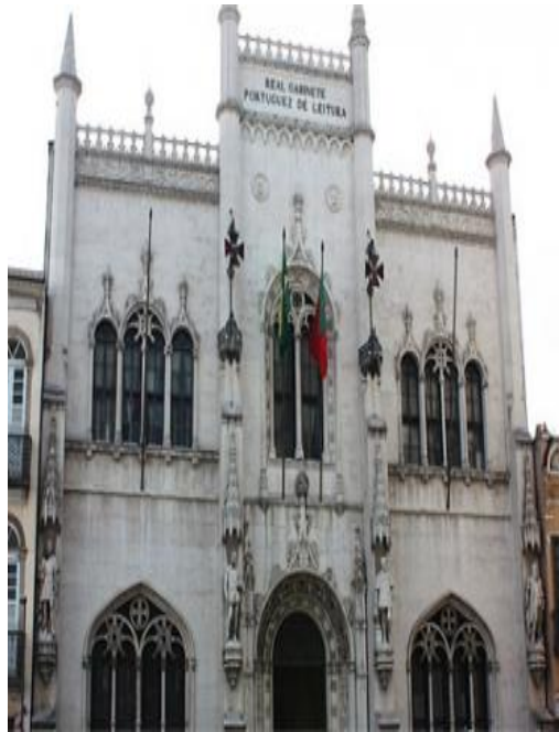
Figura 5: Gabinete Português de Leitura do Rio de Janeiro
