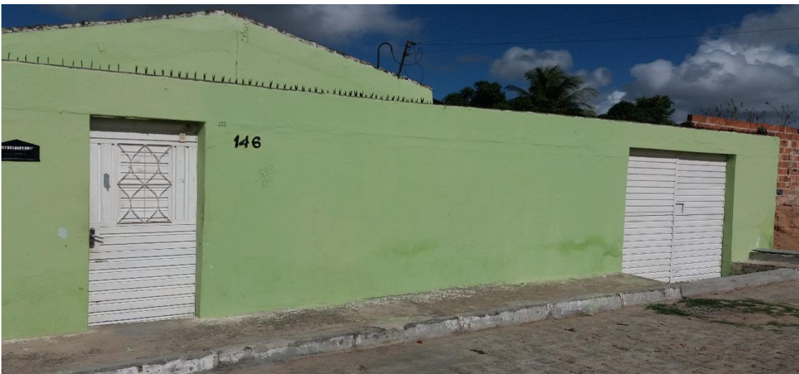
Figura 8: Antigo Cabaré de Tonha ( atualmente casas residenciais), Figura 9: Antiga Pousada Central ( Atualmente Prédio Comercial) e Figura 10: Antiga Casa de Campo ( Atualmente casa residencial).
