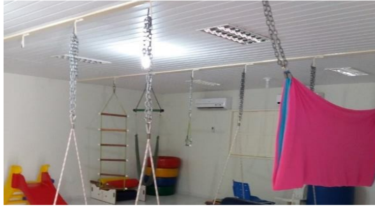
Figura 11 - Vigas metálicas para fixação de equipamentos.
