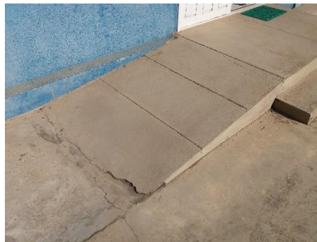
Figura 15 - Rampa de acesso à recepção.
