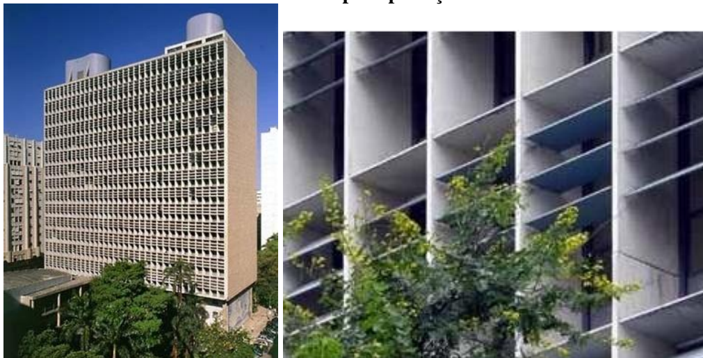
Figura 14 - Ministério da Educação e Saúde, Rio de Janeiro, 1936. Detalhe do sistema de brises utilizado para proteção das aberturas
