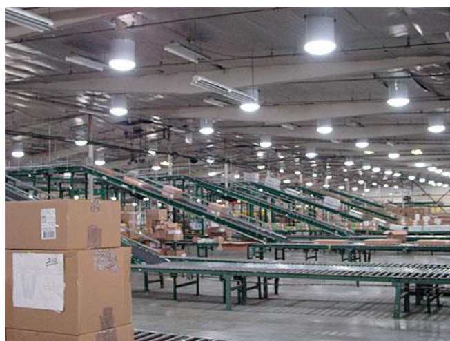
Figura 18 - Aplicação de dutos de luz em ambiente industrial
