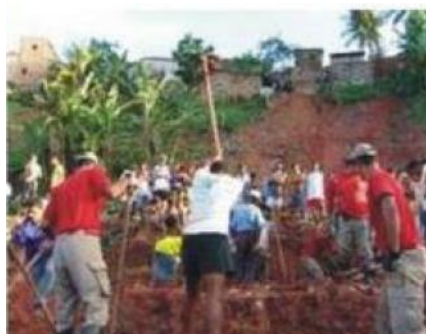
Figura 9: Trabalho da população e Defesa Civil para resgatar pessoas soterradas por deslizamento na Grota do Ouro Preto em 2004.
