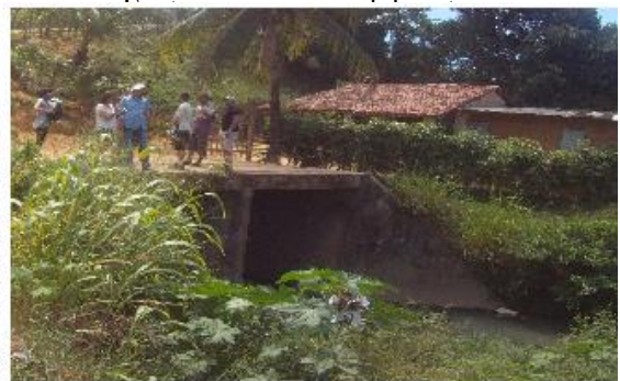
Figura 24: Vista frontal do Bueiro na Grota do Aterro.
