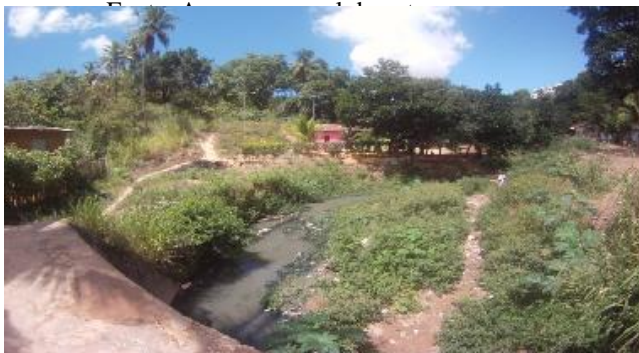
Figura 23: Bueiro na Grota do Aterro. Vista aproximada do Riacho Reginaldo.
