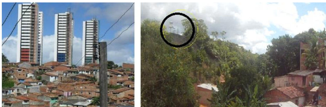
Figura16: Localização de empreendimentos imobiliários no topo de encosta no Vale do Reginaldo.
