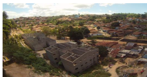
Figura 20: Vista aérea de prédios do Projeto de Revitalização do Vale do Reginaldo atingidos por deslizamento.
