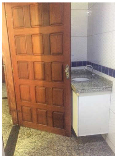
Figura 130- Abertura de porta impossibilitada pelo lavatório no Banheiro 2.
