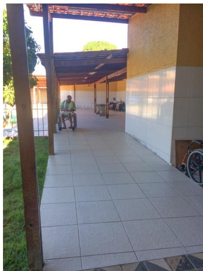
Figura 65- Rampa 1 - está no acesso à área de convivência 2.
