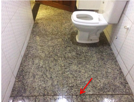
Figura 131- Indicação do desnível do Banheiro 2.
