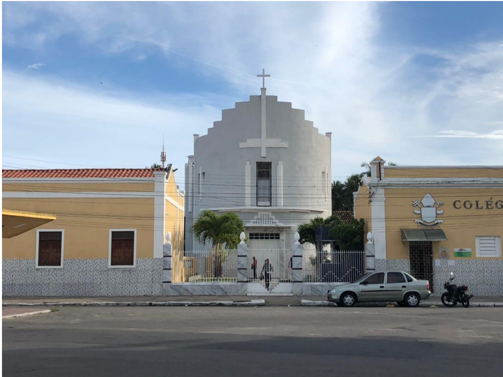
Figura 49- Fachada frontal da Casa do Pobre.
