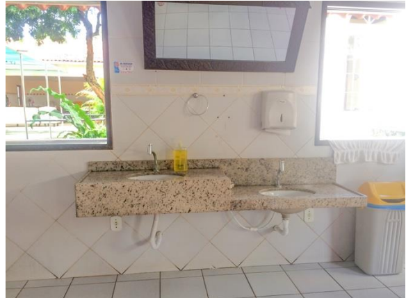
Figura 33- Lavatórios do Refeitório.
