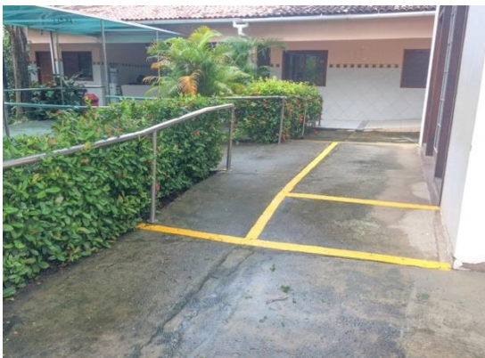
Figura 22- Vista da rampa de acesso à capela.
