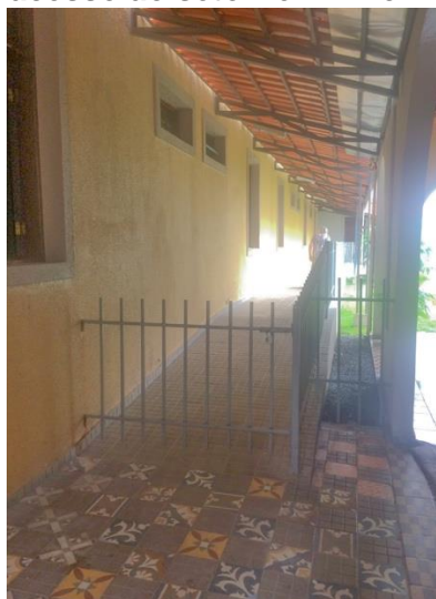
Figura 66- Rampa 2 - está no acesso ao setor feminino.
