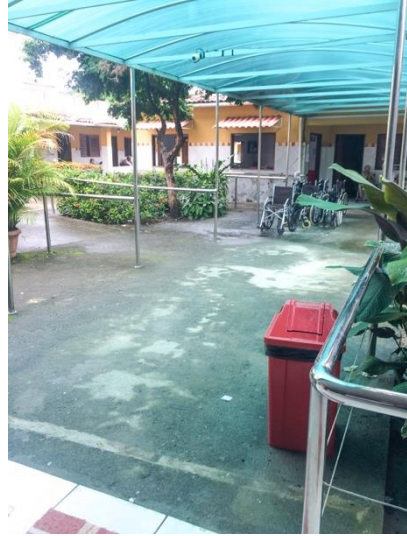
Figura 19- Vista da calçada que interliga as edificações.
