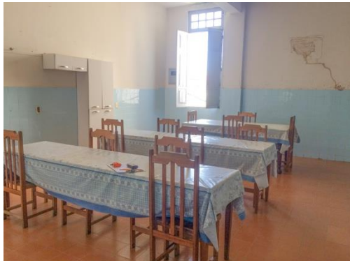
Figura 71- Parte inicial do refeitório.
