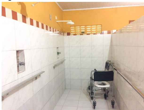
Figura 103- Área de banho do Banheiro 3.
