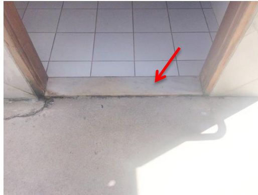
Figura 24- Soleira do refeitório desnivelada em relação ao final da rampa de acesso.
