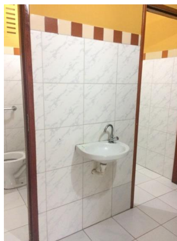
Figura 101- Lavatório do Banheiro 3.
