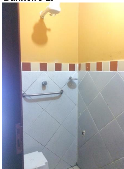
Figura 96- Área de banho do Banheiro 2.
