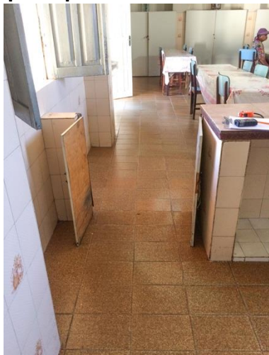
Figura 73- Passagem do balcão para a parte principal do refeitório.
