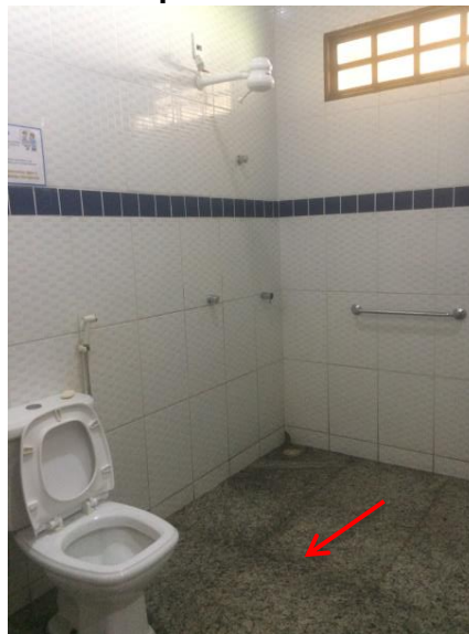
Figura 90- Área do banho do Banheiro 1 com desnível indicado pela seta.
