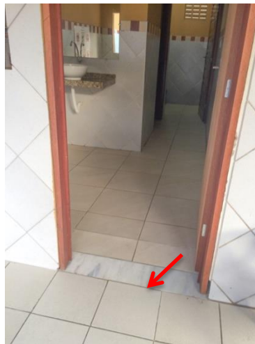
Figura 98- Desnível na passagem da porta de acesso ao Banheiro 2.
