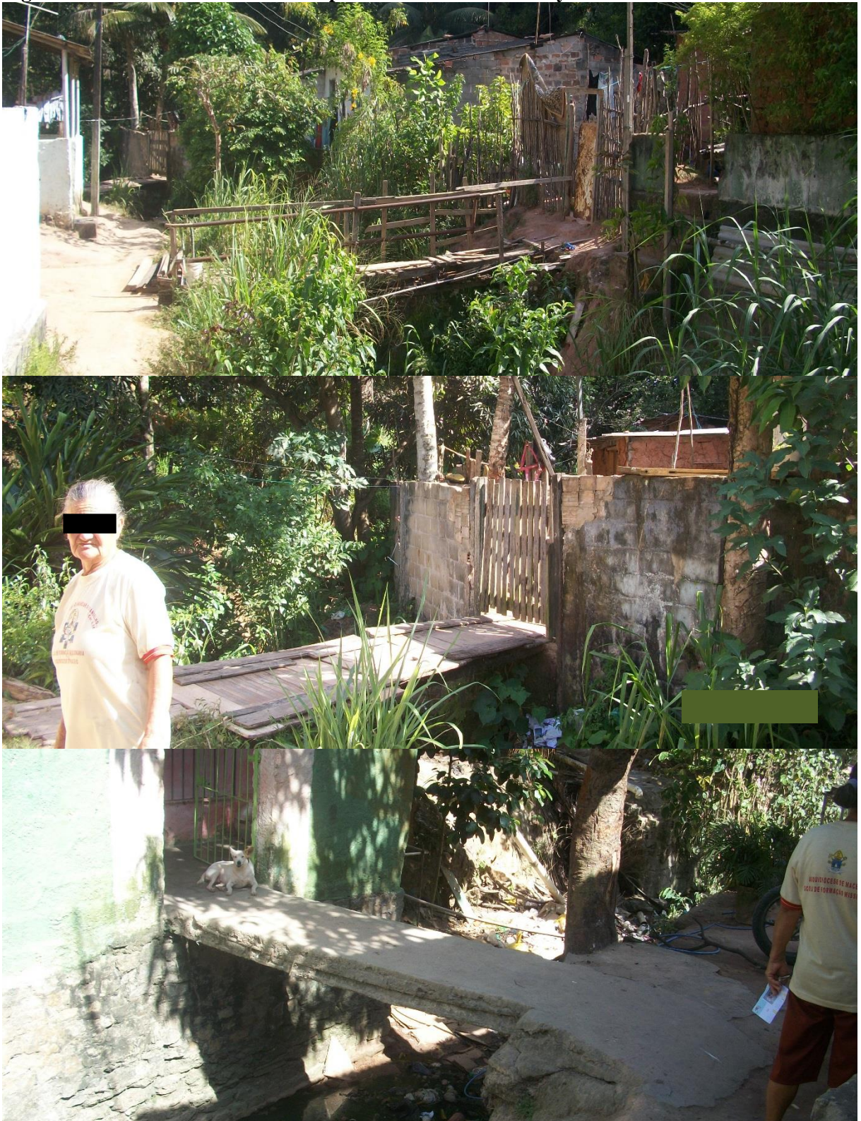
Figura 13 - Acessos as residências improvisados na Grota da Cycosa.
