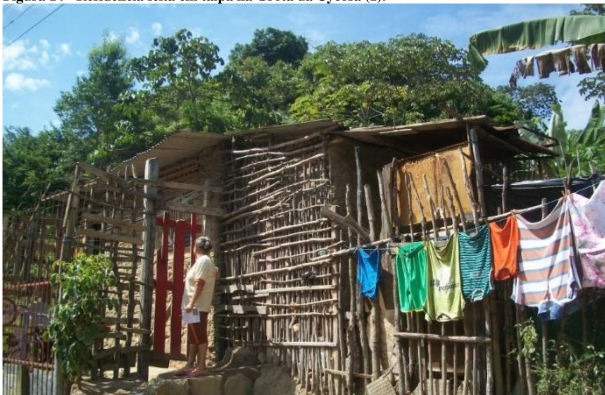
Figura 14 - Residência feita em taipa na Grota da Cycosa (1).
