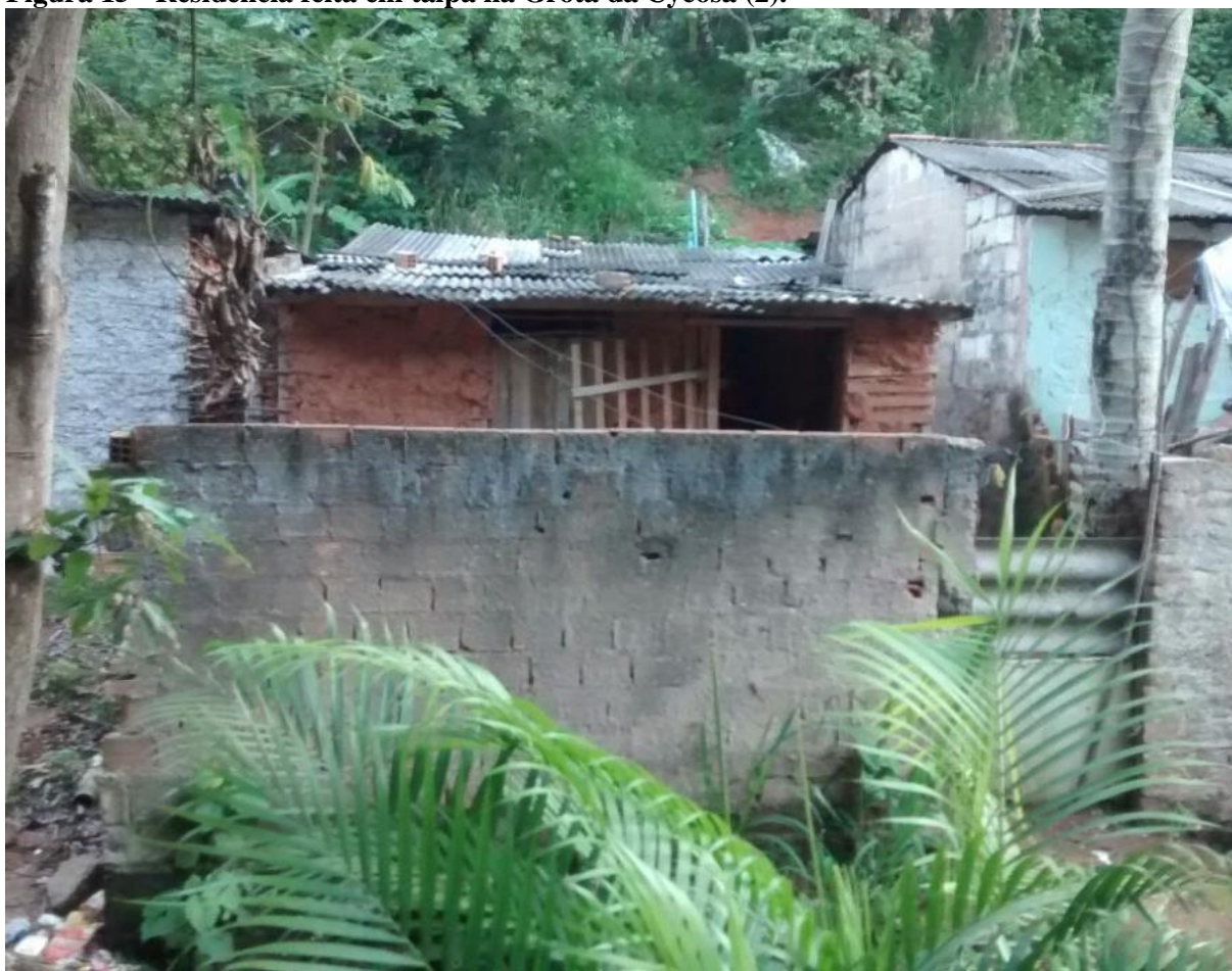
Figura 15 - Residência feita em taipa na Grota da Cycosa (2).
