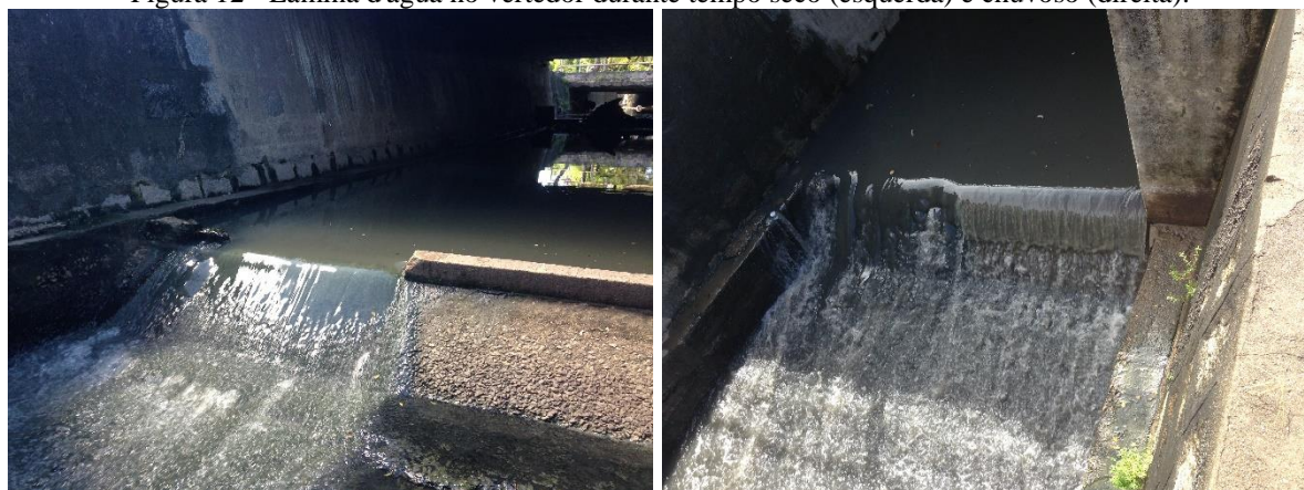
Figura 12 - Lâmina d'água no vertedor durante tempo seco (esquerda) e chuvoso (direita).
