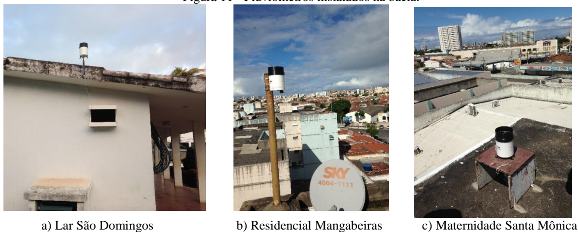
Figura 11 - Pluviômetros instalados na bacia.
