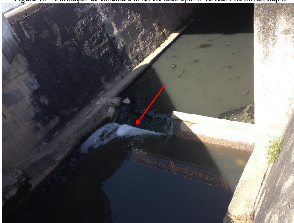
Figura 48 – Formação de espuma e nível elevado após o vertedor na foz do Sapo.
