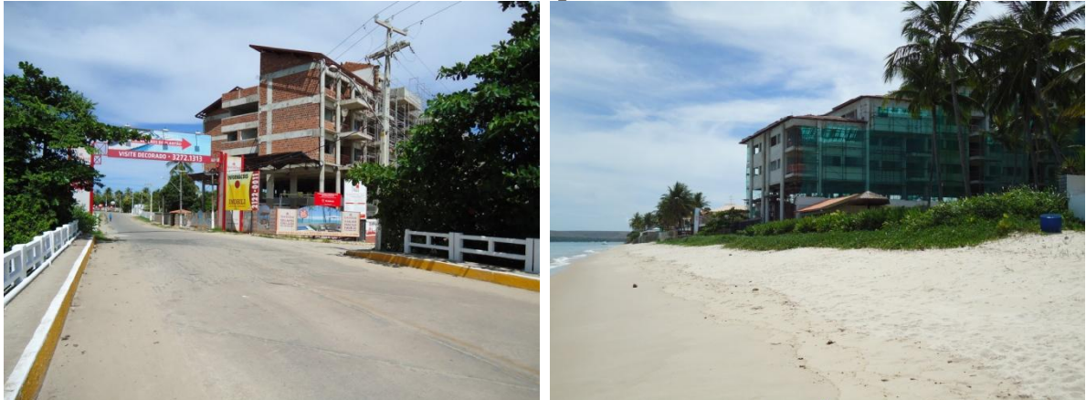
FIGURA 16 – Vista da entrada e do acesso à praia do condomínio em construção/BSM
