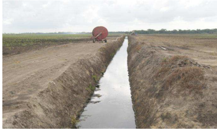
Figura 4 - Transporte da vinhaça por canal para irrigar por aspersão.
