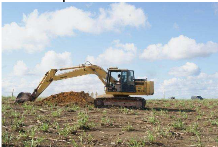
Figura 2 - Máquina que foi utilizada para fazer as trincheiras nas áreas.
