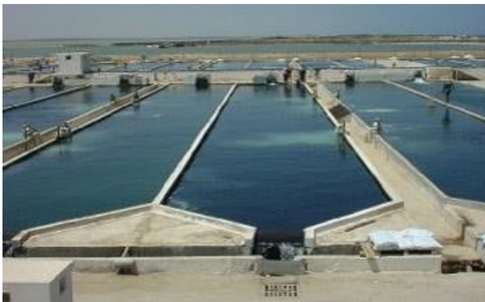
Figura 5 - Sistemas de fluxo contínuo (raceway) em tanques retangulares.
