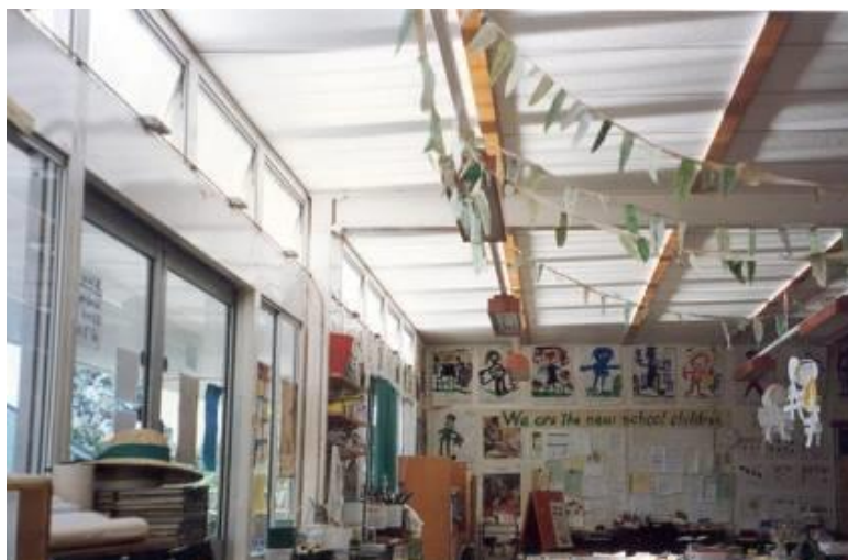
Figura 21 - Aplicação de um painel de corte a laser em uma escola na cidade de Brisbane, Austrália. Os painéis estão aplicados nas janelas altas.
