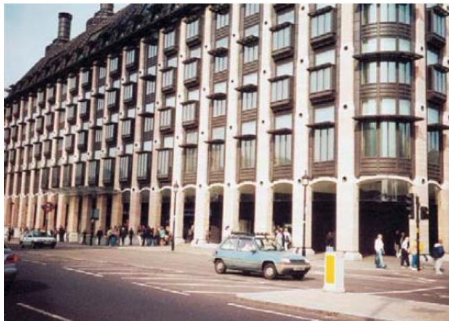
Figura 2 - Aplicação de marquise como protetor solar em aberturas laterais Fonte: PHILLIPS, 2004
