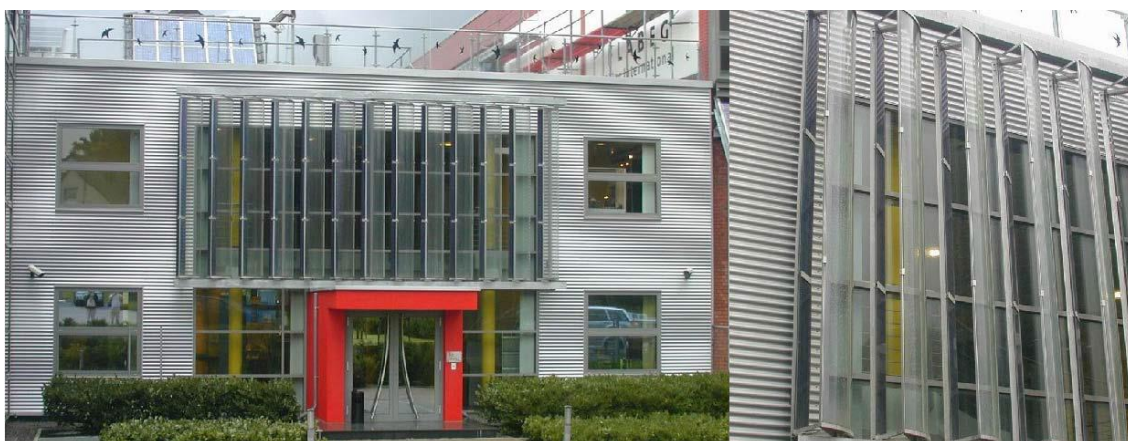
Figura 14 - Sistema de sombreamento direcional utilizando HOEs na Shell Solar Factory, Gelsenkirchen Fonte: SANTOS, 2009
