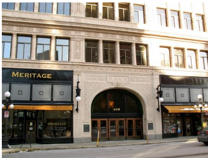
Figura 11 - Edifício Hamm, 1915. As estruturas quadradas sobre as vitrines são painéis prismáticos Fonte: Interior Design, 2016
