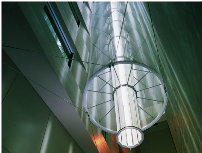
Figura 7 - Difusor de luz associado ao heliostato instalado no Edifício Morgan, em Washington DC Fonte: Revista Metropolismag, 2016
