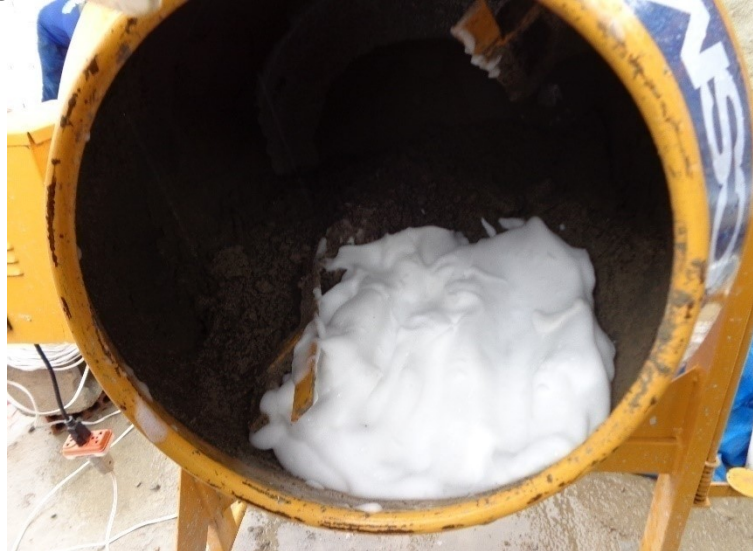
Figura 14 – Espuma adicionada ao concreto base
