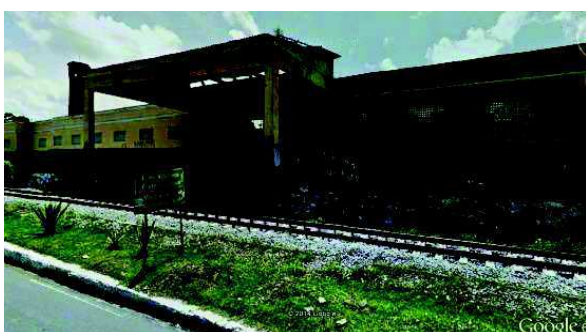
Figura 66: Fábrica Progresso em ruínas em 2012. Fonte: Google Earth (2012).
