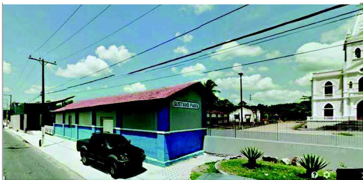
Figura 70: Estação Férrea de Gustavo Paiva.
