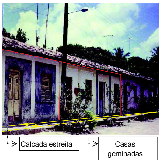
Figura 37: Casas de operários com calçada estreita. Fonte: Castro e Xavier (1996).
