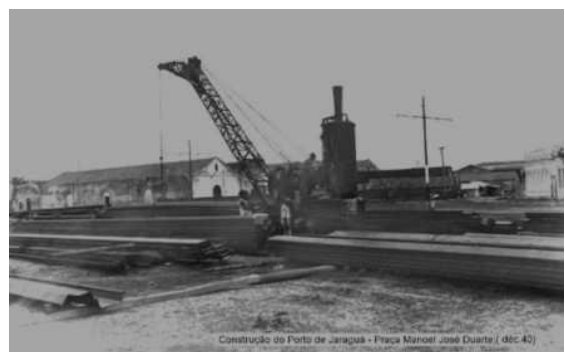
Figura - 04 : Construção do porto de Jaraguá, década de 40.
