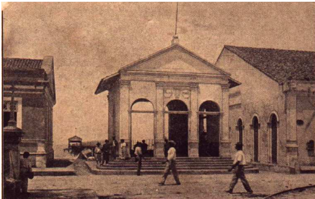
Figura 50 - Portal da Ponte de Embarque. Imagem antiga utilizada no processo de associação de imagens e ancoragem.
