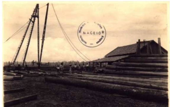
Figura - 03: Construção do porto de Jaraguá, década de 40.
