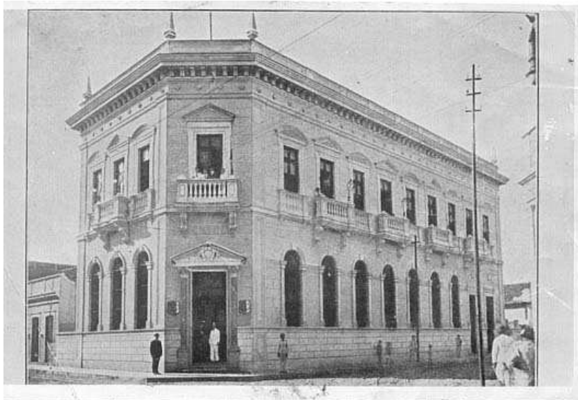
Figura 70 - Banco de Alagoas, Rua da Alfandega, 1920. Imagem antiga utilizada no processo de associação de imagens e ancoragem.
