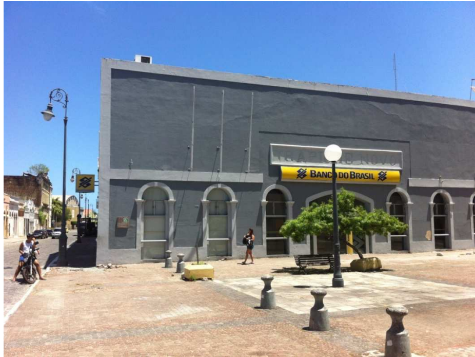
Figura 45 - Banco do Brasil, antigo Trapiche Novo, 2014. Imagem atual utilizada no processo de associação de imagens e ancoragem.
