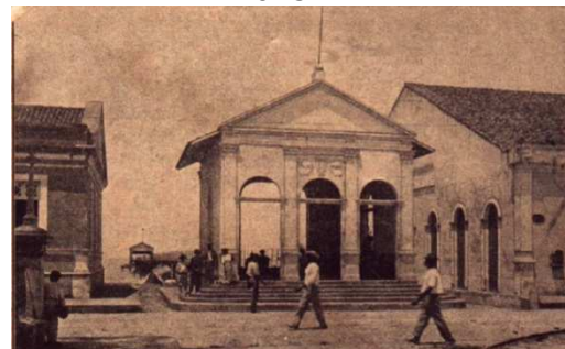
Figura 08 - Portal da Ponte de embarque, Jaraguá. Fonte: Instituto Histórico e Geográfico de Alagoas, 2013.
