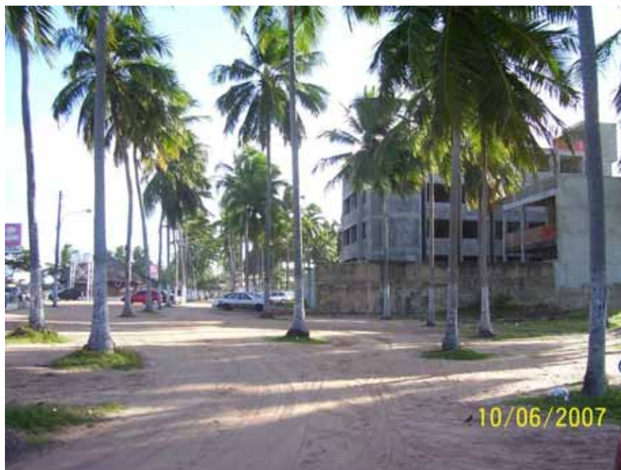
Ilustração 11: Obras retomadas de um prédio bastante próximo das barracas na praia de Guaxuma. Fonte: Frederika Araújo, 2007.
