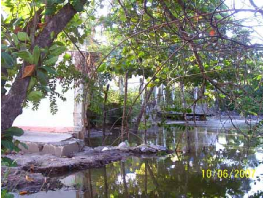
Ilustração 8: Construções às margens do Rio Guaxuma, desrespeito às normas de recuo mínimo de 30m. Fonte: Frederika Araújo, 2007.
