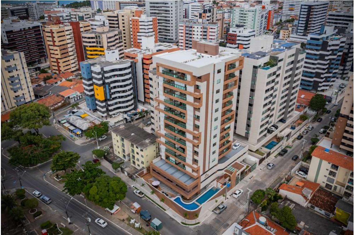
Figura 31: Vista aérea do Edifício Grand Fortune, no bairro da Ponta Verde.
