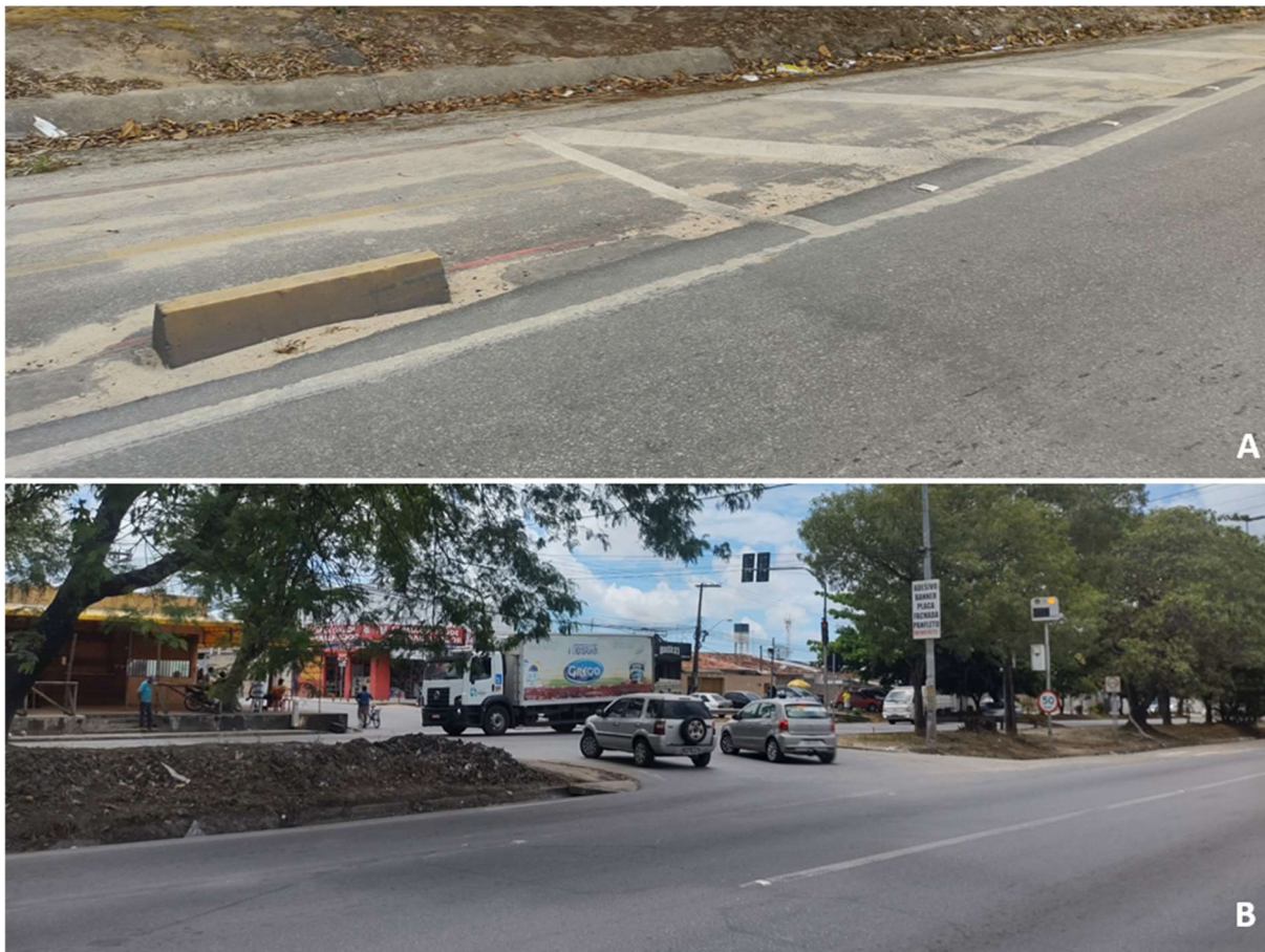
Figura 65: Trecho interrompido da ciclofaixa da BR-104 (A) para acesso ao conjunto Eustáquio Gomes (B) cerca de 110 metros depois.
