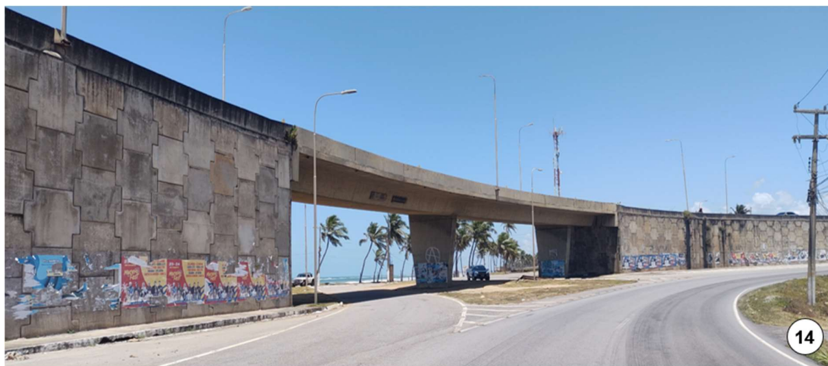
Figura 48: Viaduto do Detran.
