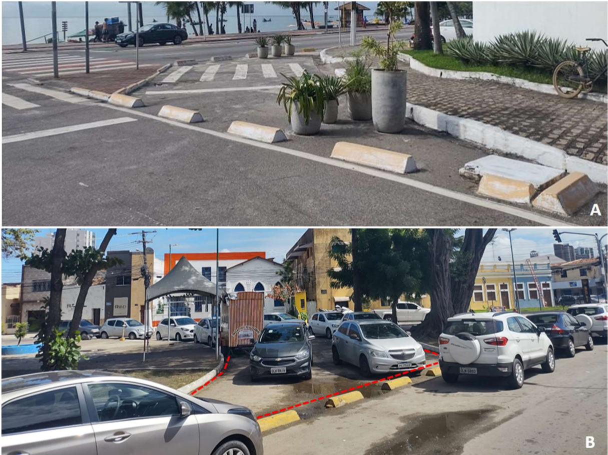
Figura 68: Antiga saída da avenida Júlio Marques Luz para a Álvaro Otacílio (A) e contorno da Praça Rayol, com destaque para a extinta conexão com a rua Campos Sales (B).
