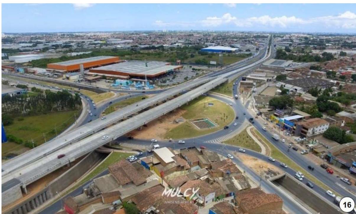
Figura 50: Vista aérea do viaduto da PRF.
