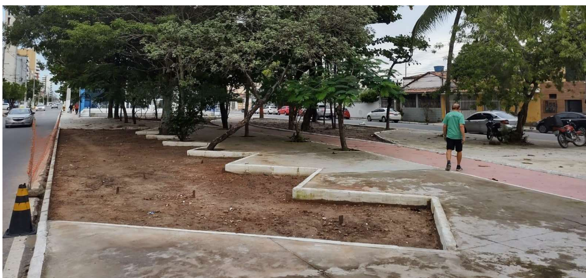
Figura 69: Obras em execução no Parque da Mulher
