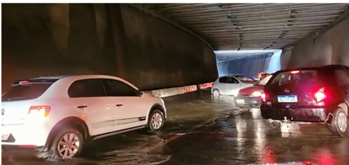
Figura 78: Alagamento deixa trânsito caótico em túnel do viaduto da PRF.
