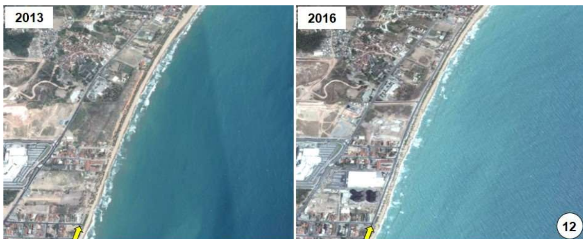
Figura 46: Área em que está localizada a Via Litorânea em 2013 e 2016.
