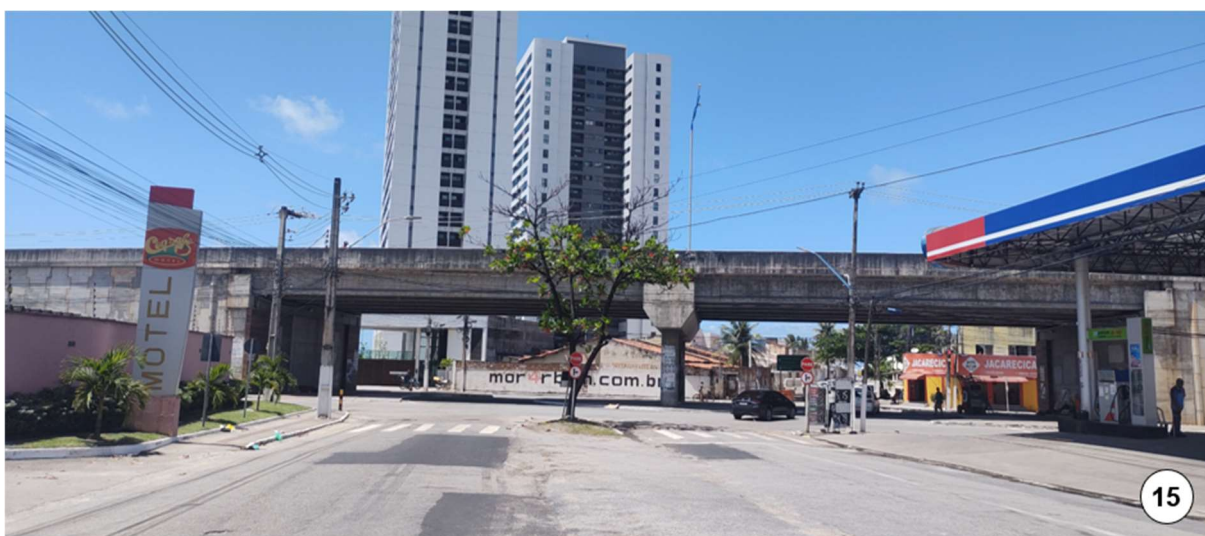
Figura 49: Viaduto de Jacarecica.
