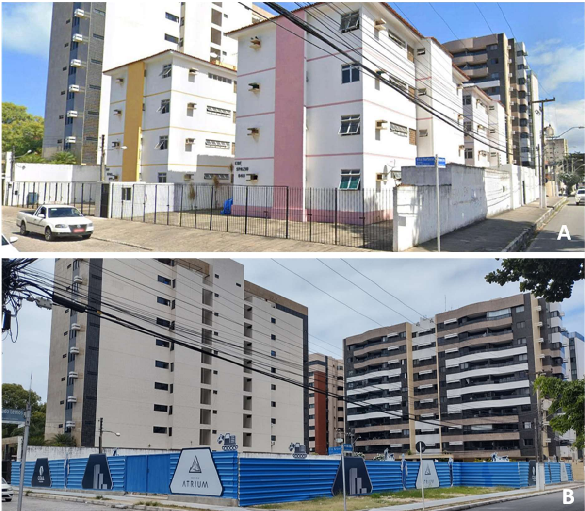
Figura 32: Localização do futuro Edifício Atrium, para o qual os antigos edifícios foram demolidos.
