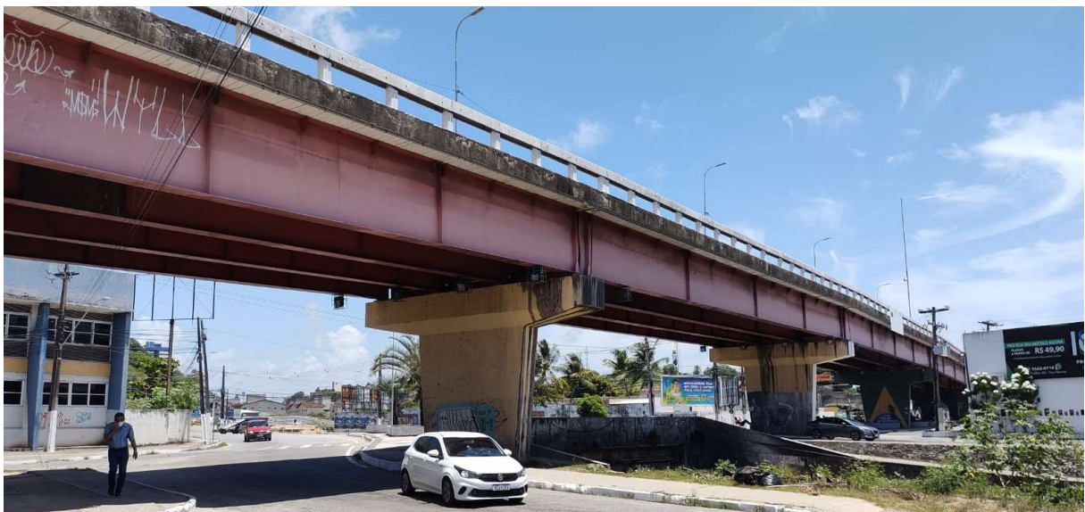
Figura 21: Viaduto Ib Gatto Falcão
