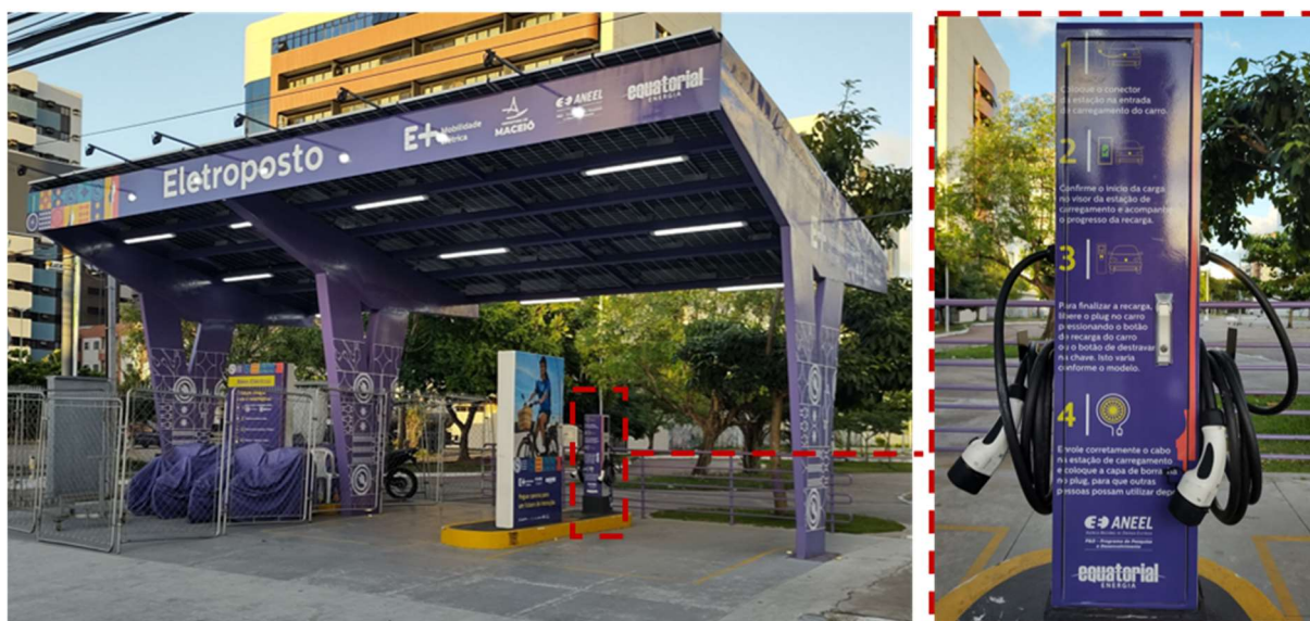
Figura 80: Eletroposto instalado entre os segmentos 1 e 2 do corredor Vera Arruda.
