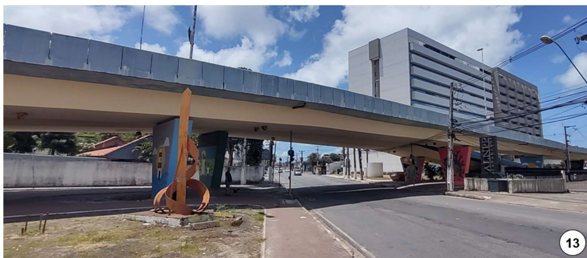
Figura 47: Viaduto Industrial João Lyra.
