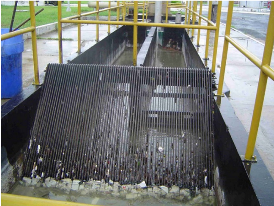
Figura 4. Gradeamento de esgoto
