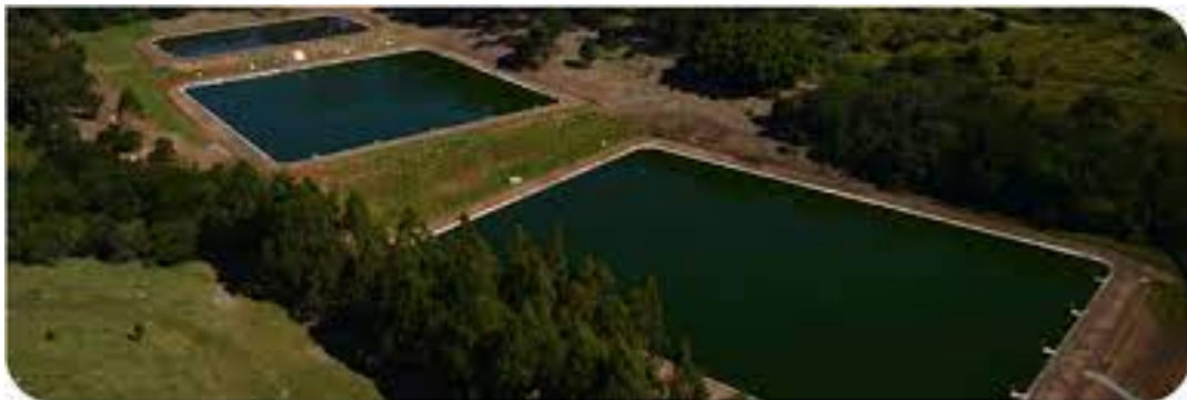
Figura 6. Lagoas de estabilização
