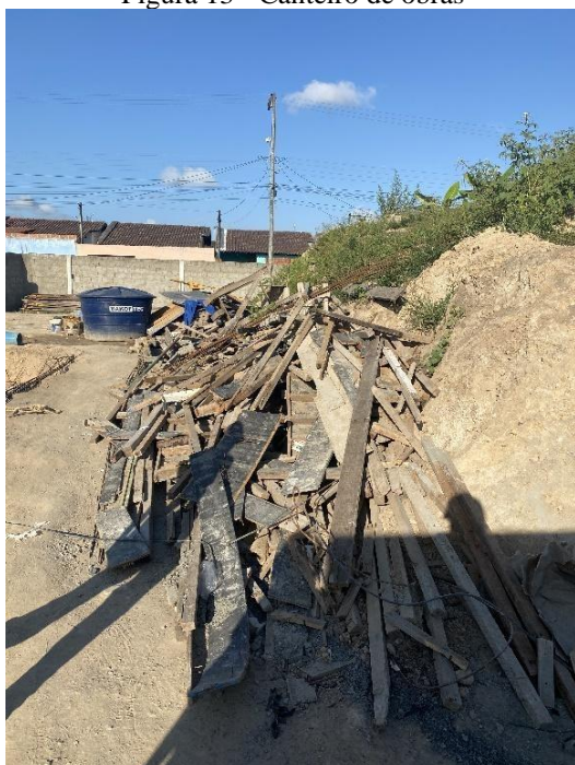
Figura 13 - Canteiro de obras
