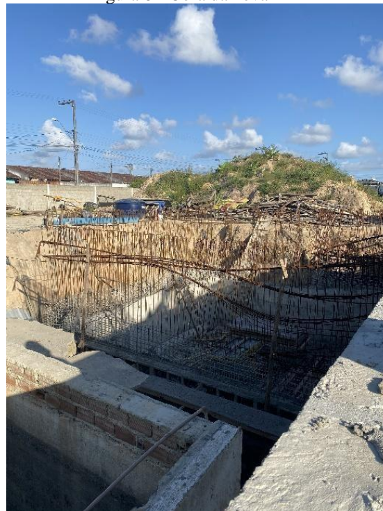
Figura 8 - Obra da nova ETE
