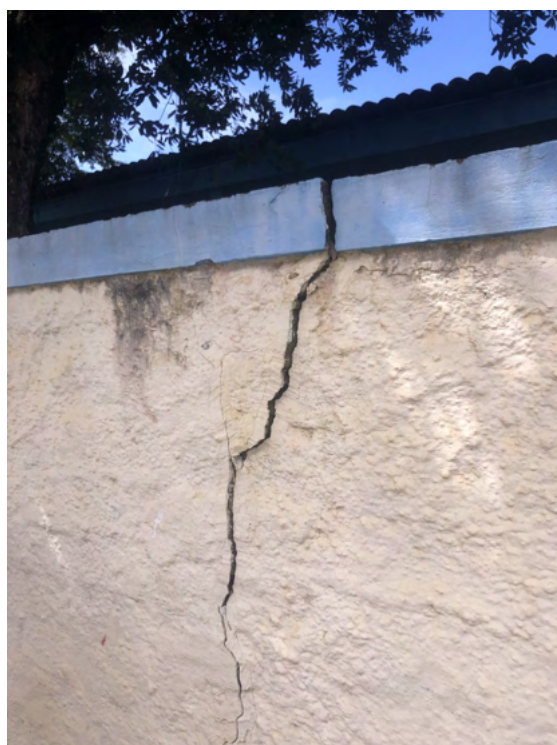
Figura 20 – Fissura no muro da EE Professor José Vitorino da Rocha
