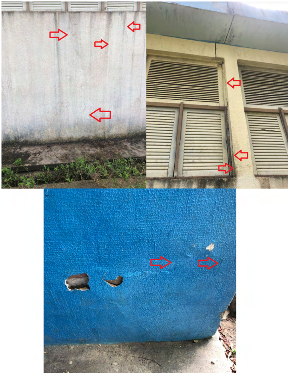
Figura 33 – Manifestações patológicas nas fachadas das edificações
