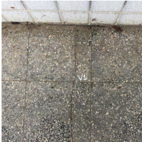
Figura B.48 – Fissura V1 (14/07/2021)
