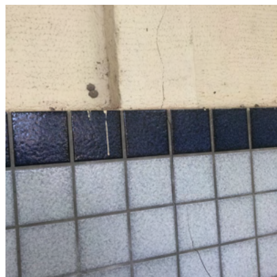
Figura B.66 – Fissura V10 (14/07/2021)
