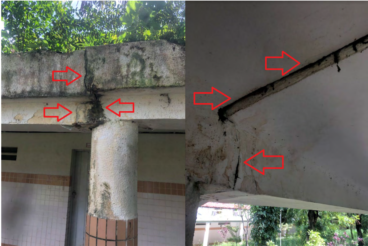
Figura 32 – Visualização da fissura T23
