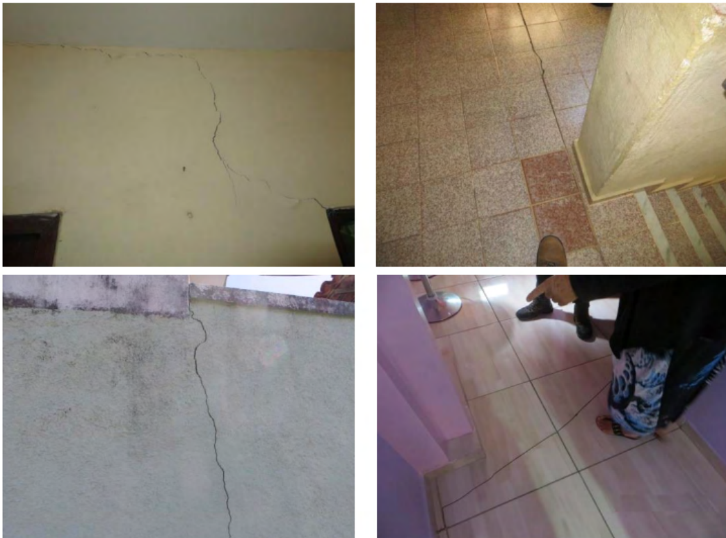
Figura 8 – Características das trincas que retratam a área de média instabilidade no terreno
