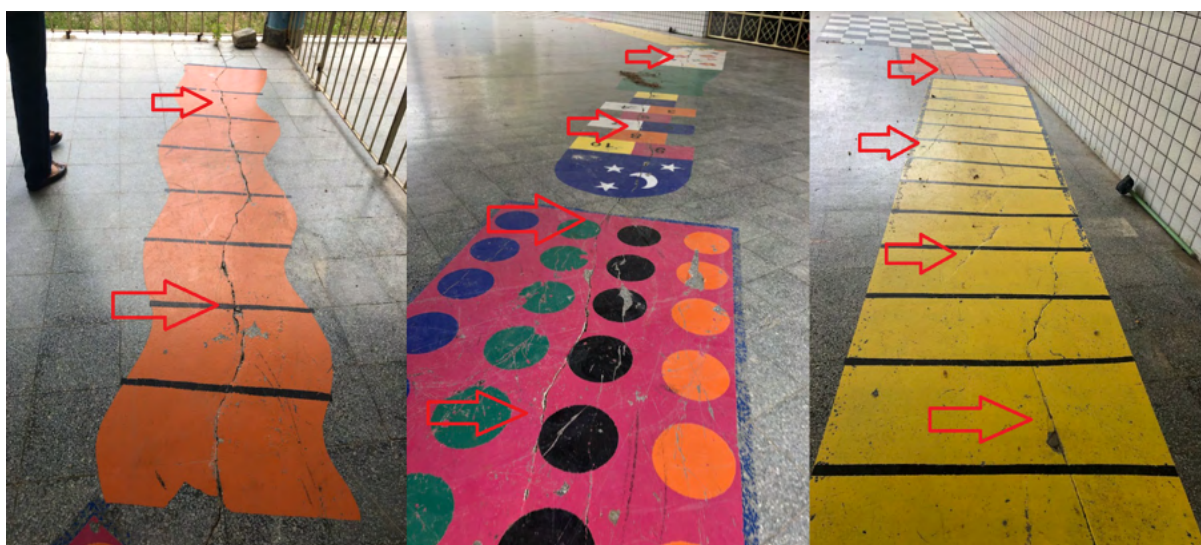
Figura 30 – Visualização da fissura V11
