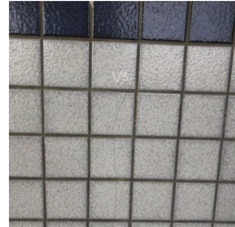
Figura B.52 – Fissura V3 (14/07/2021)
