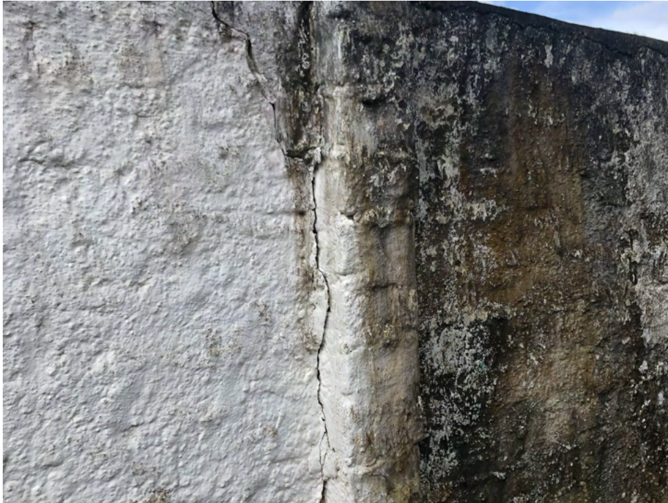
Figura 28 – Manchas e fissuras no muro da EE Professor José Vitorino da Rocha
