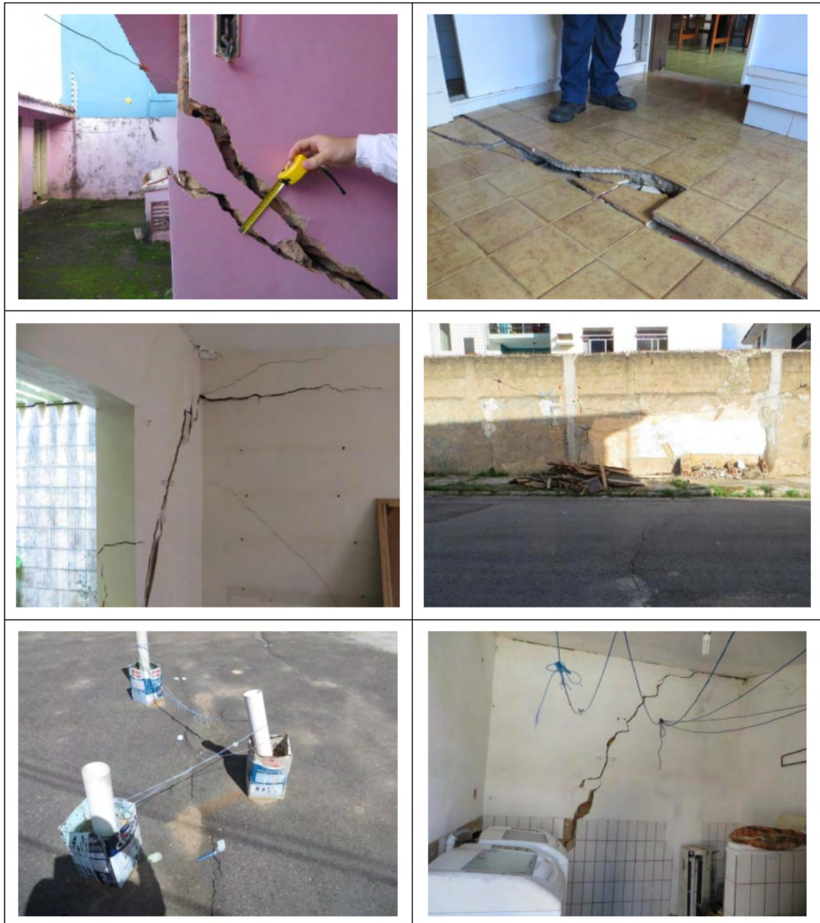
Figura 7 – Características das trincas que retratam a área de alta instabilidade no terreno
