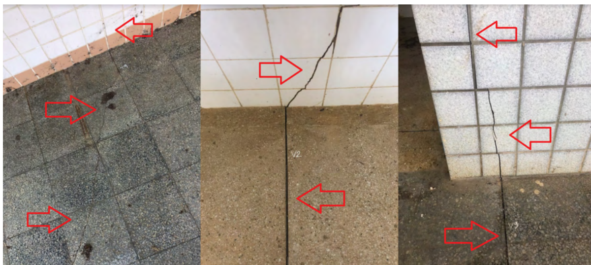
Figura 31 – Visualização das fissuras T9, V2 e V9
