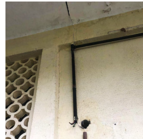
Figura B.58 – Fissura V6 (14/07/2021)
