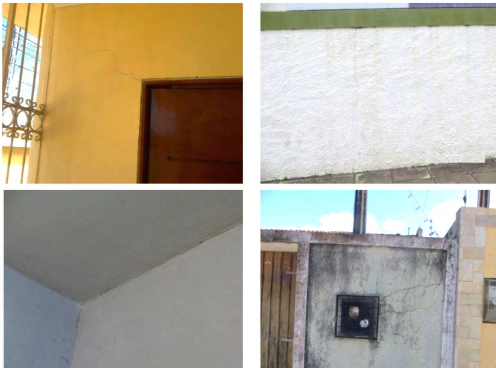
Figura 9 – Características das trincas que retratam a área de baixa instabilidade no terreno
