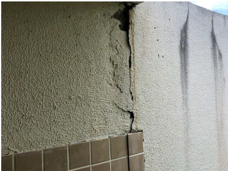
Figura 29 – Manchas e fissuras em parede externa da EE José Correia da Silva Titara
