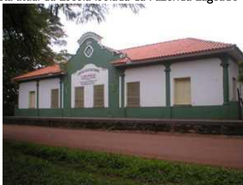
Figura 2 - Vista atual da Escola Isolada da Fazenda Lageado - Botucatu/SP
