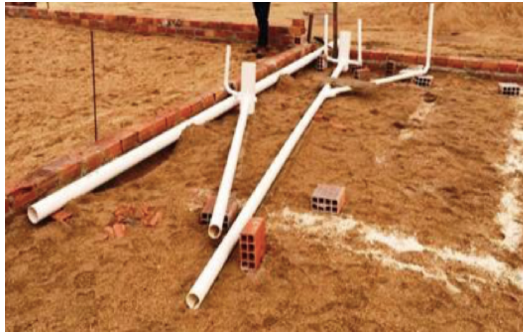
Figura 4: Exemplo de passagem de instalações hidráulicas antes da concretagem do Radier.
