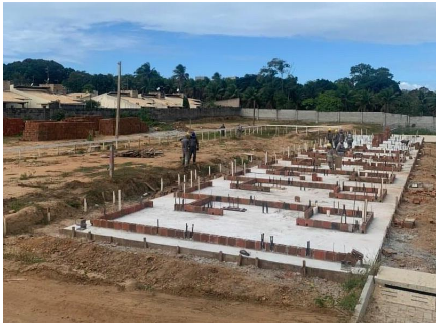
Figura 6: Exemplo de Radier após a concretagem.
