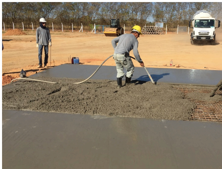
Figura 5: Exemplo de Radier sendo concretado.
