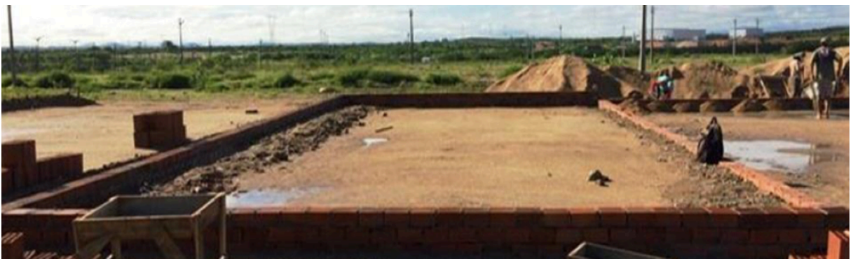
Figura 3: Exemplo de escavação de Radier e delimitação com alvenaria.
