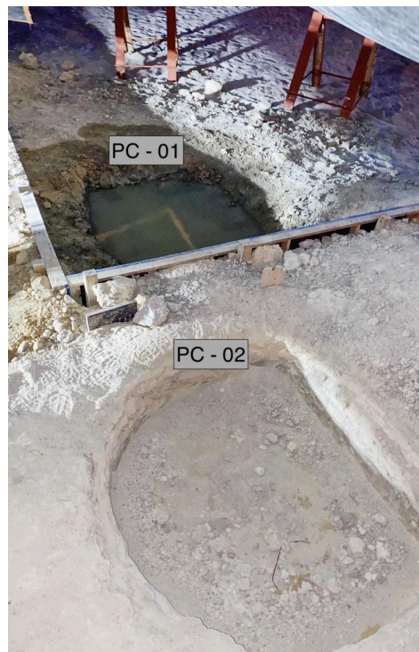
Figura 22: Escavações dos ensaios PC-01 (solo-cimento pré-inundado) e PC-02 (solo natural).
