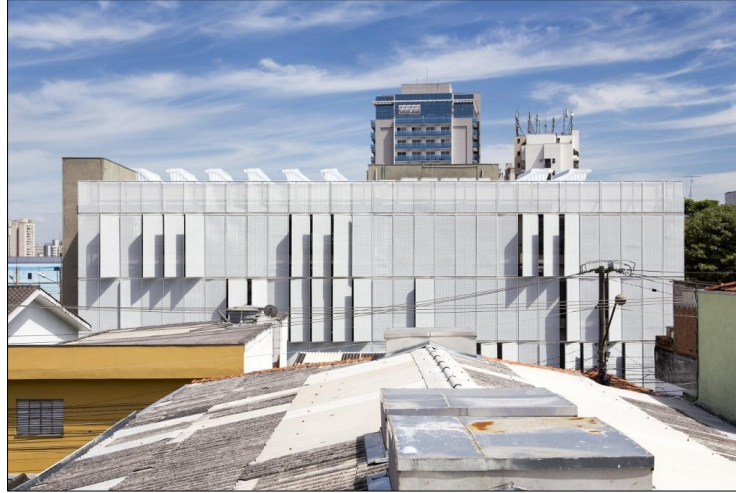
Figura 19 – Fachada da escola evidenciando as chapas de alumínio instaladas.
