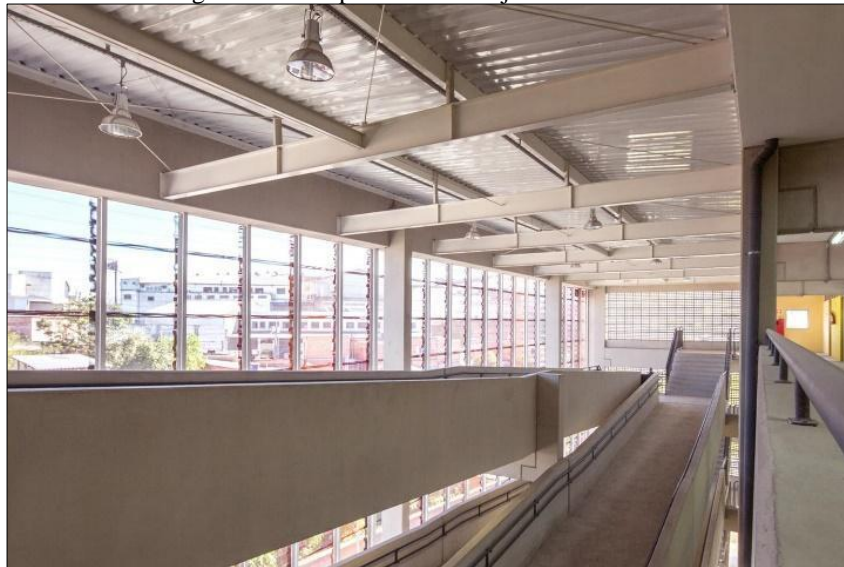
Figura 10- Rampas e escada adjacente da escola.
