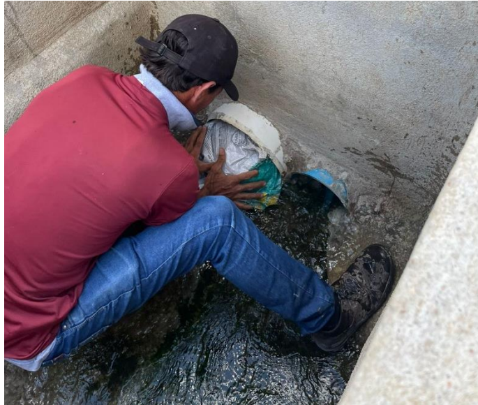
Figura 2- Fechamento da saída da caixa de drenagem com sacos de rafia preenchidos com areia molhada.
