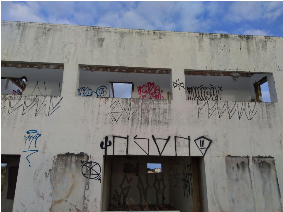
Figura 14 - Posto de combustível abandonado VI. Barro Duro, Av. Juca Sampaio.
