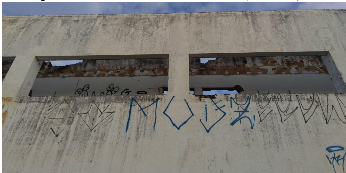
Figura 15 - Posto de combustível abandonado VII. Barro Duro, Av. Juca Sampaio.
