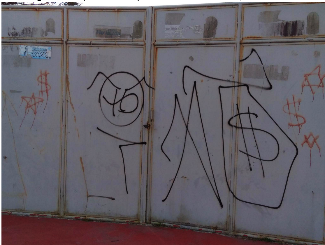
Figura 45 - Pequenas intervenções III. Tabuleiro dos martins, Rua sem nome.
