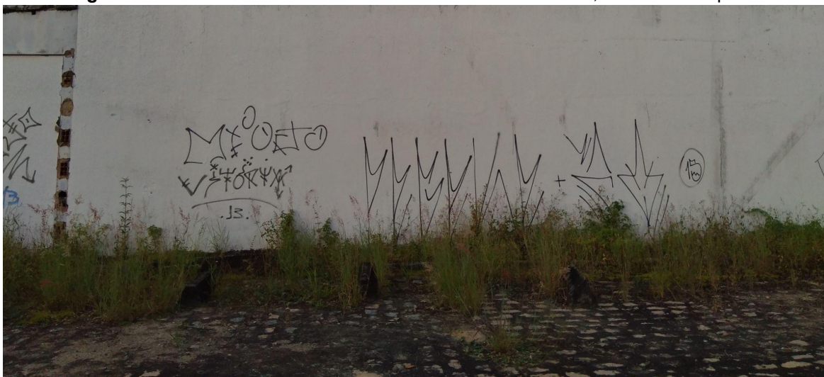
Figura 20 - Posto de combustível abandonado XII. Barro Duro, Av. Juca Sampaio.
