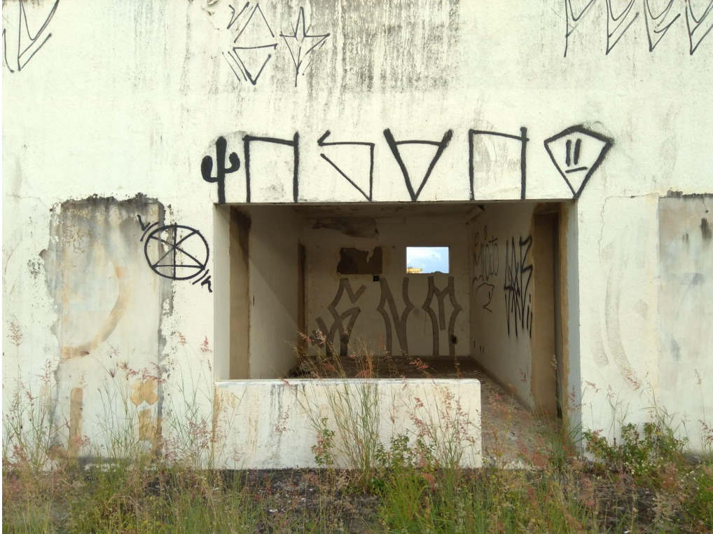
Figura 13 - Posto de combustível abandonado V. Barro Duro, Av. Juca Sampaio.
