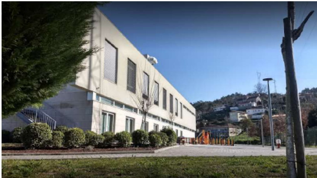
Figura 23 - Fachada Escola Básica da Ponte
