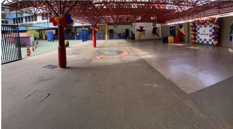
Figura 7 - Espaço do estrelão - Colégio Santa Úrsula - unidade pré escolar
