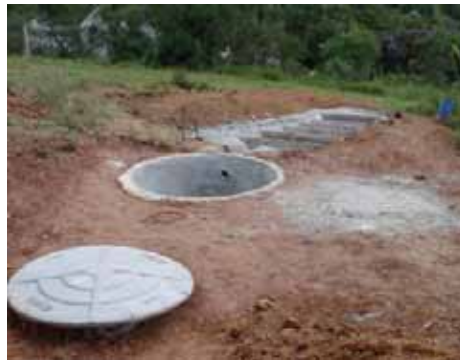
Foto 04: Biosistema em construção composto de biodigestor Fonte: http://www.verdesaine.net/saneamento_ecologico
