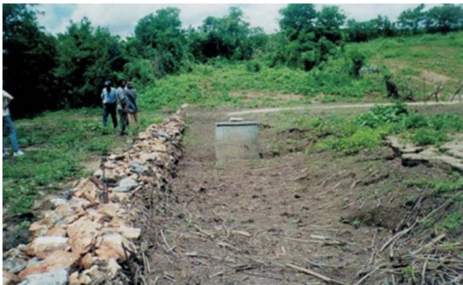
**Figura 5.** Barragem subterrânea submersa, modelo Costa & Melo. Pesqueira, PE, 2016.
