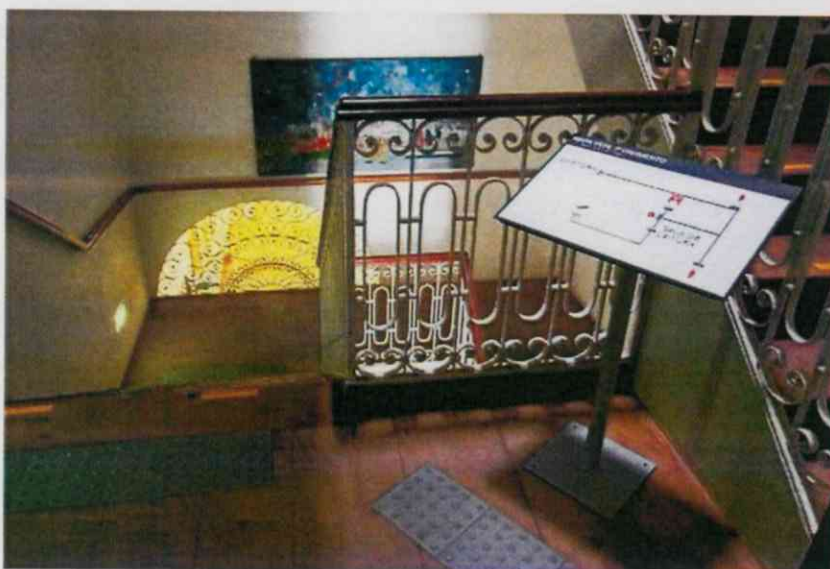
Figura 3 – escadarias da biblioteca pública com acesso a deficientes visuais.
