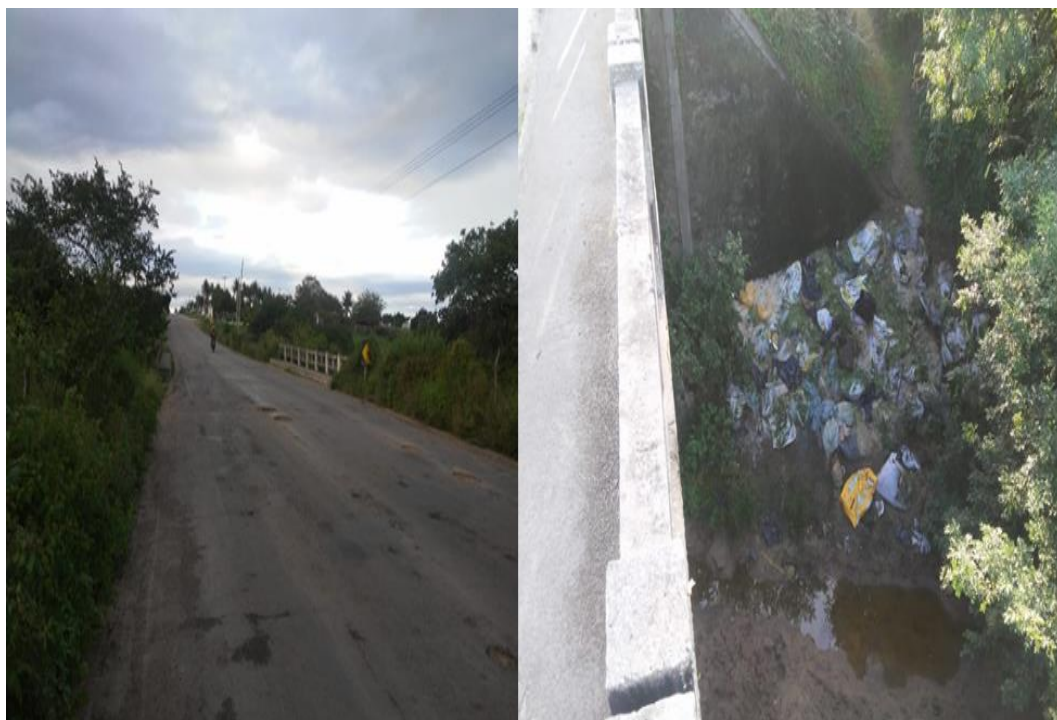
Figura 7 –Ponte do Riacho do Urubu em São José da Tapera-AL BR 220
