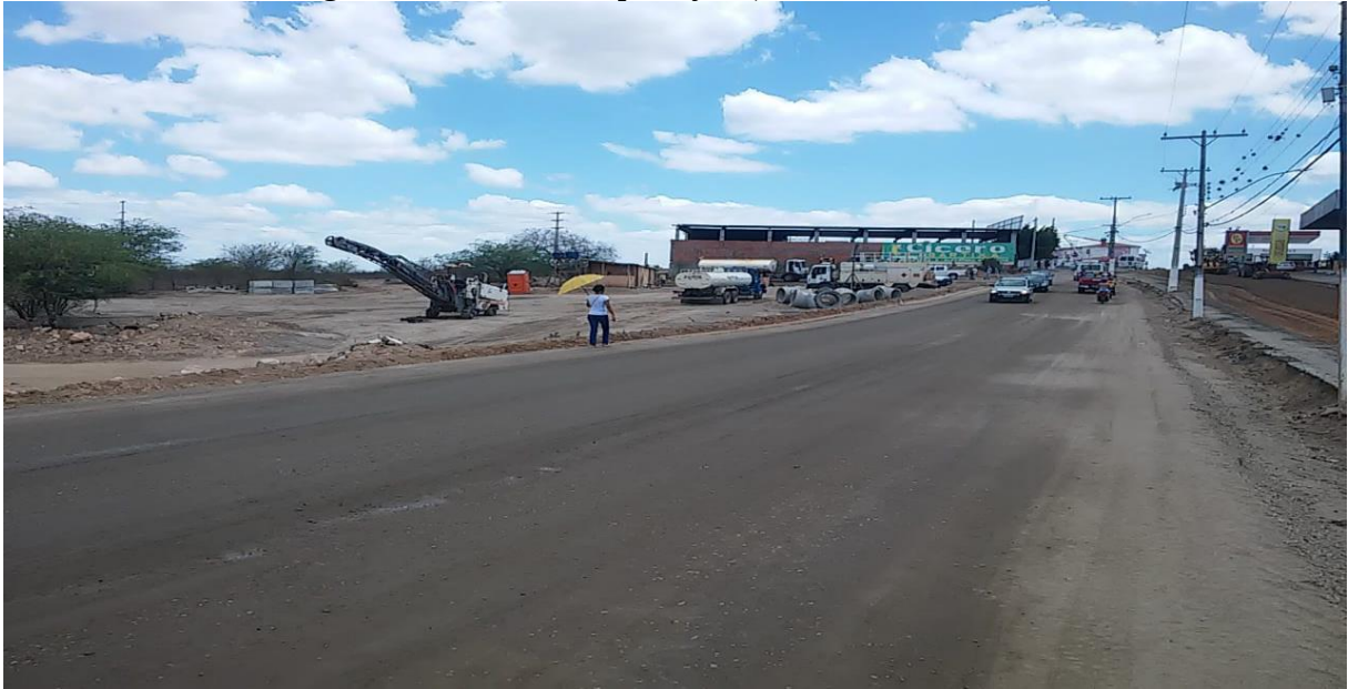
Figura 06: Início da duplicação (Rua Manoel Ribeiro)
