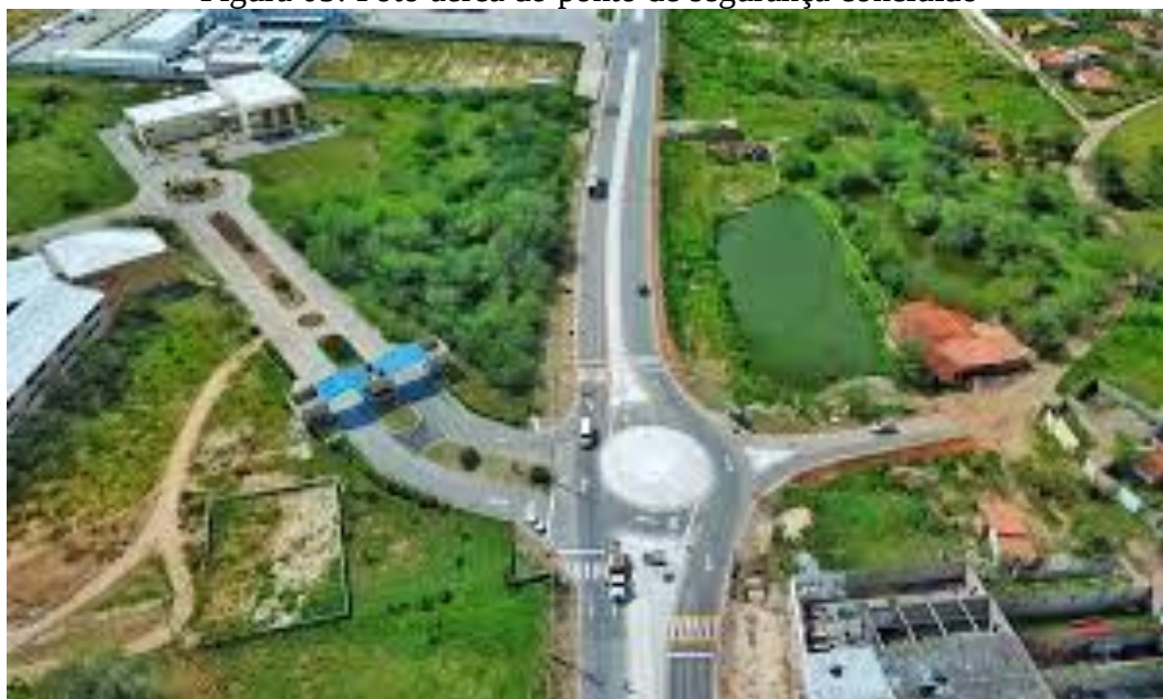
Figura 05: Foto aérea do ponto de segurança concluído
