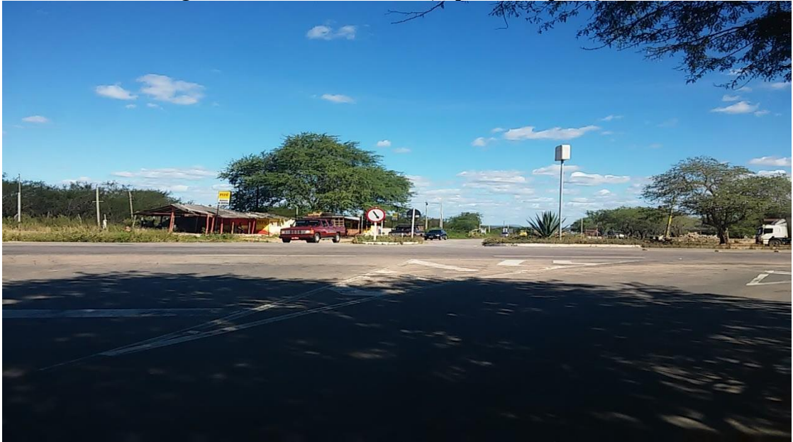
Figura 13: Acesso à BR-423 (depois da duplicação)
