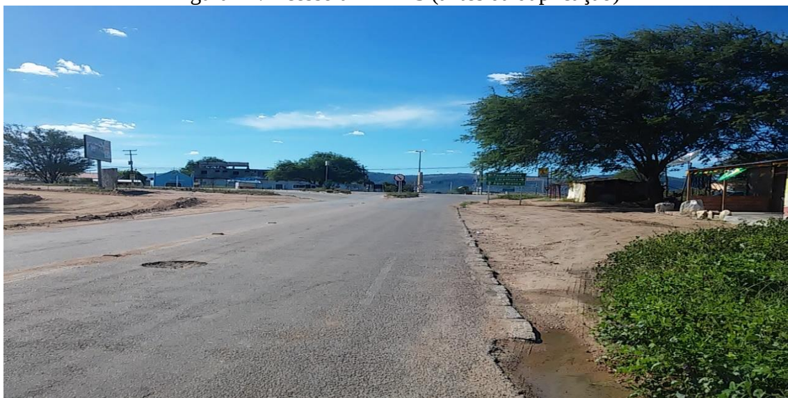
Figura 12: Acesso à BR-423 (antes da duplicação)
