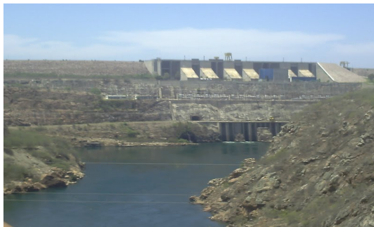
Figura 13: Vista da barragem de Paulo Afonso.
