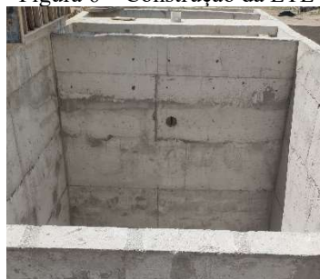
Figura 6 – Construção da ETE
