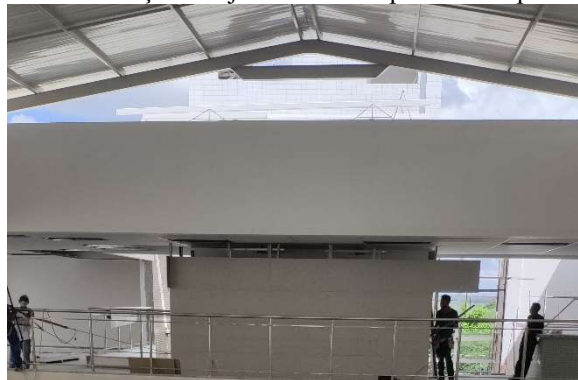
Figura 8 – Vidraçarias e janelas do complexo do 2º pavimento
