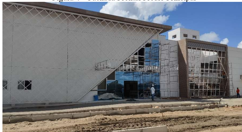
Figura 4 – Fachada Frontal Prédio Principal
