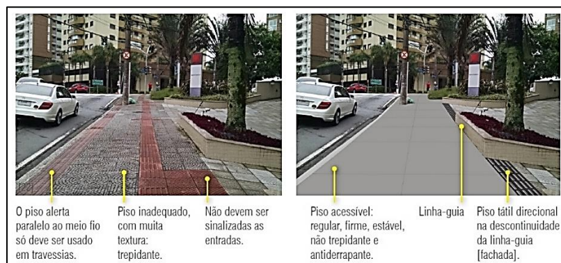
Figura 17: Exemplos do uso de Piso Tátil (incorreto e correto).
