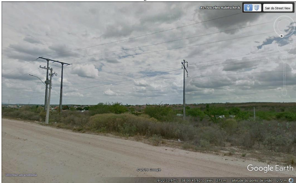
IMAGEM 3: Antiga Rede de Alta Tensão.
