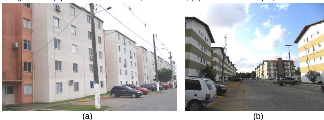
Figura 21 - (a) Residencial Paraíso, Pelotas/RS; (b) Residencial Mayra, Maceió/AL.
