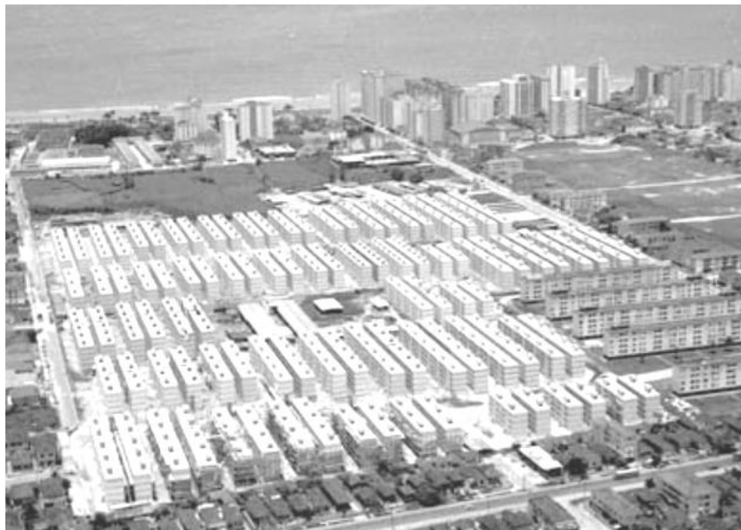
Figura 20 - Conjunto Castelo Branco, Santos/SP, foto do início de 1970.
