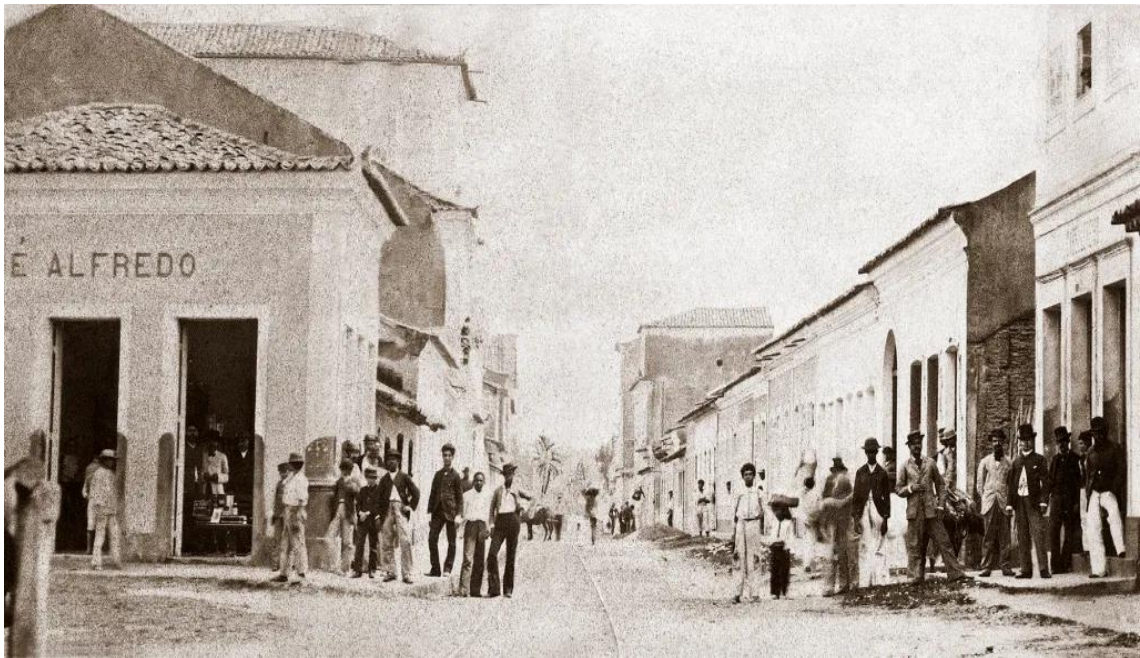
Figura 2 - Rua da Boa Vista, Maceió/AL, entre os anos de 1880 e 1890.
