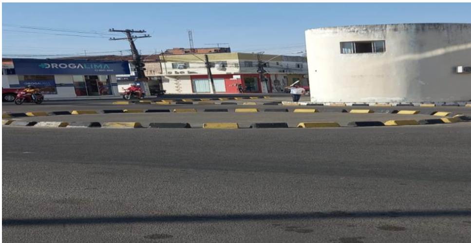
Figuras 19– Sinalizações Horizontais na cidade de Delmiro Gouveia
