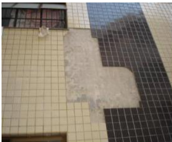
Figura 7: Deslocamento do revestimento.
