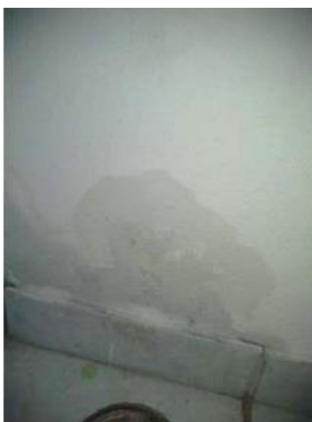
Figura 6: Manchas da área molhada.
