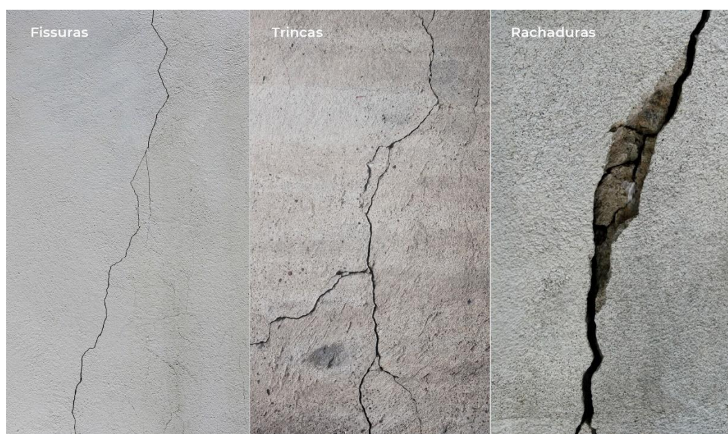
Figura 2: Fissura, trincas e rachaduras.
