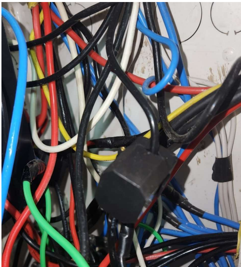
Figura 14 – “Pinça” medidor monofásico instalada
