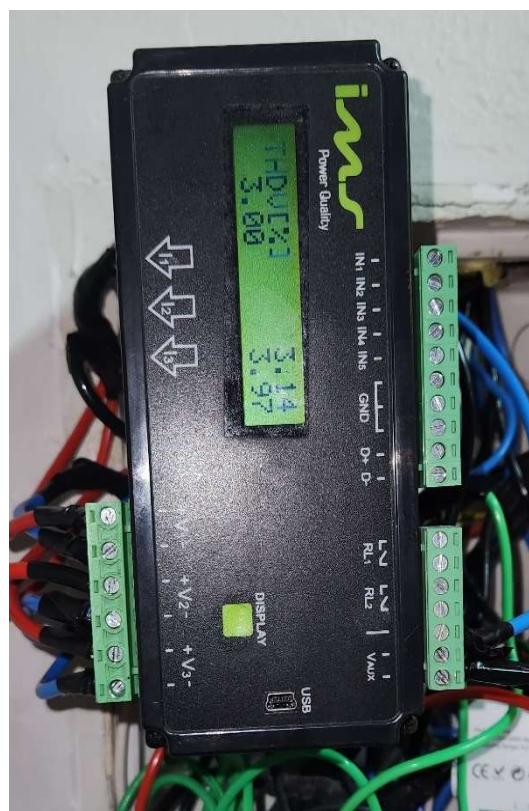
Figura 13 – Medidor trifásico instalado
