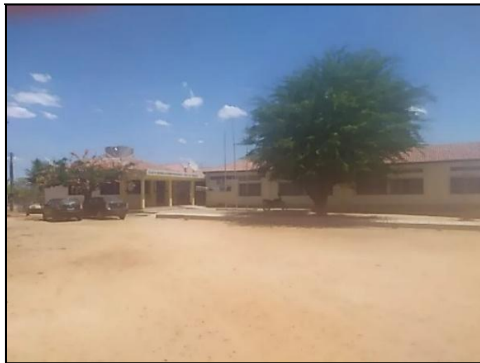
Figura 1 - Fachada da escola EREFEM São Francisco.
