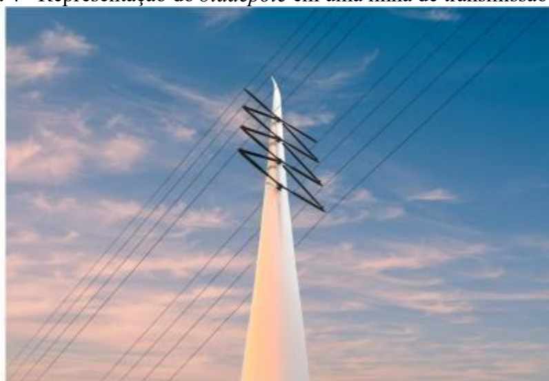
Figura 4 - Representação do blade pole em uma linha de transmissão de 230 kV.
