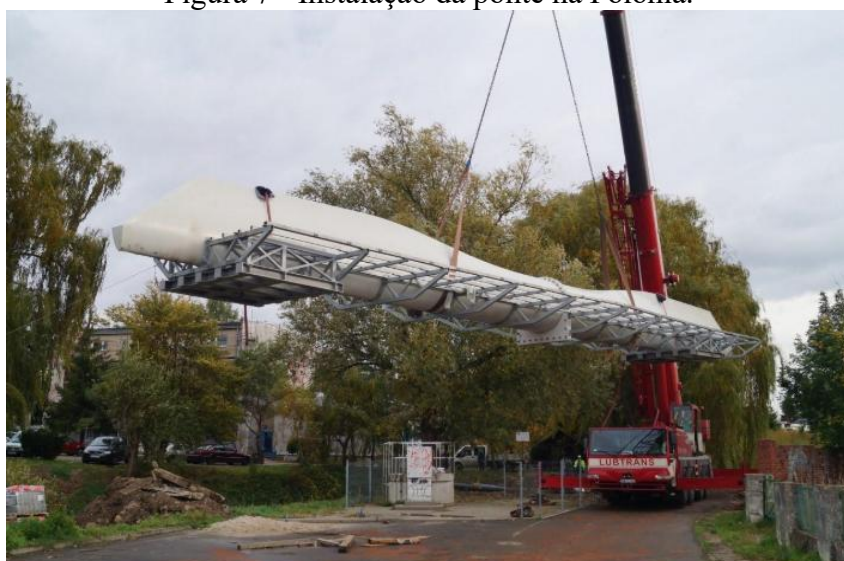
Figura 7 - Instalação da ponte na Polônia.
