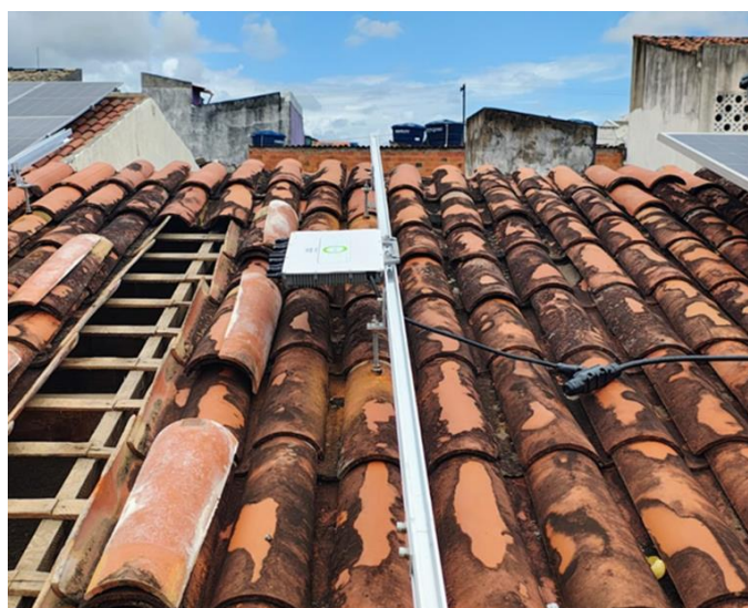
Figura 8 – Sistema 2: vista da instalação de um dos microinversores
