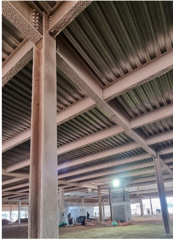
Figura 2.13 – Estruturas metálicas revestidas com argamassa projetada
