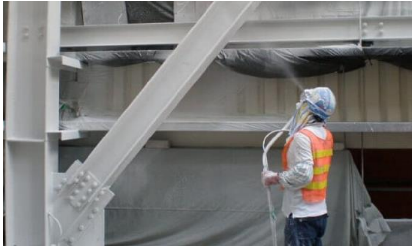
Figura 2.11 – Aplicação do revestimento intumescente
