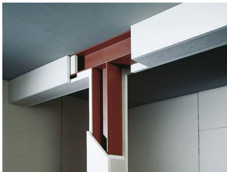
Figura 2.16 – Estrutura metálica protegida com placas de gesso
