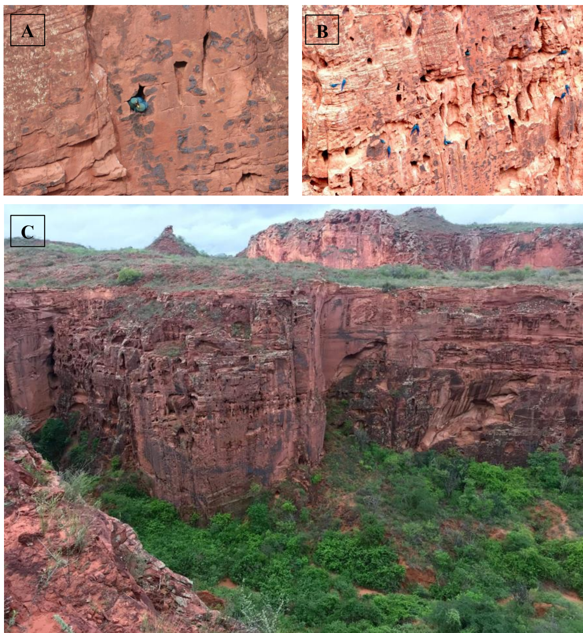
Figura 3 – Cavidades naturais (locas) (A), distância entre as locas (B), nos paredões rochosos de arenito-calcário (C)
