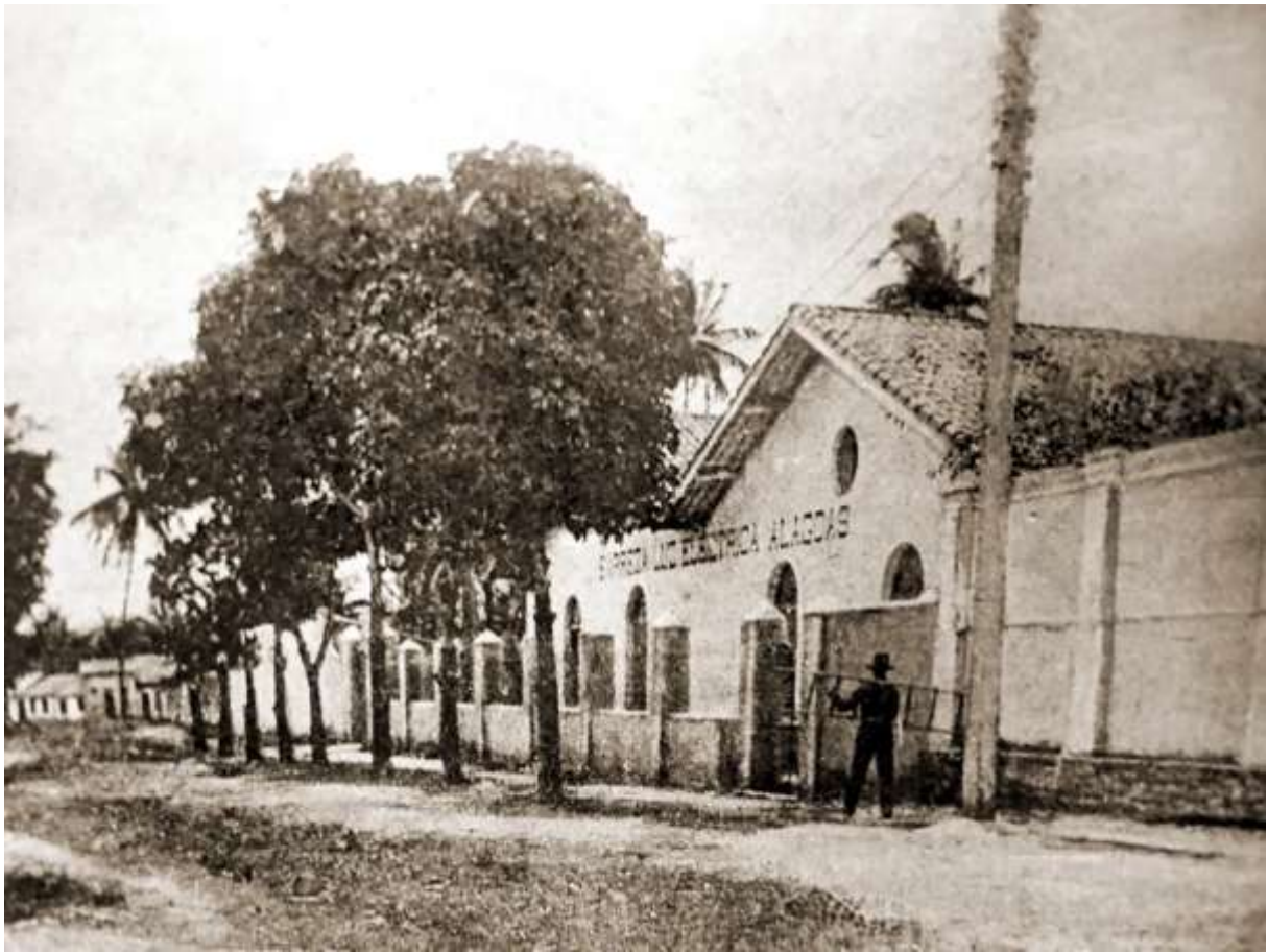
Figura 3 – Sede da Empresa Luz Elétrica de Alagoas
