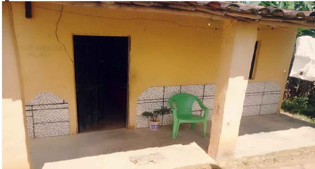
Figura 65: Casa de alvenaria no núcleo São Pedro
