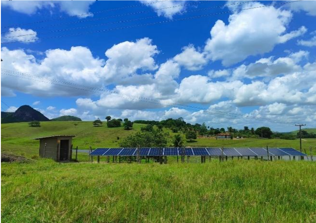
Figura 7A - Instalação de placas solares.
