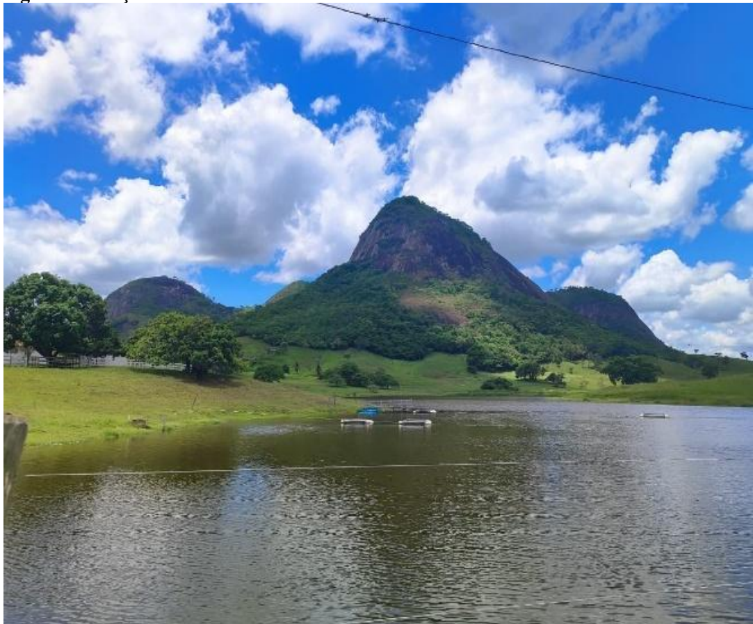
Figura 7B - Açude construído na baixada.
