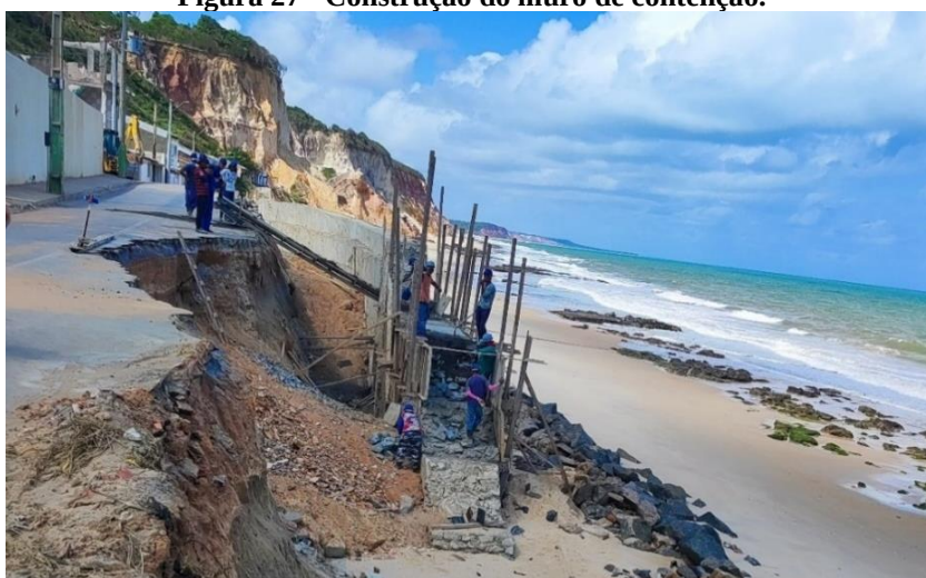
Figura 27 - Construção do muro de contenção.
