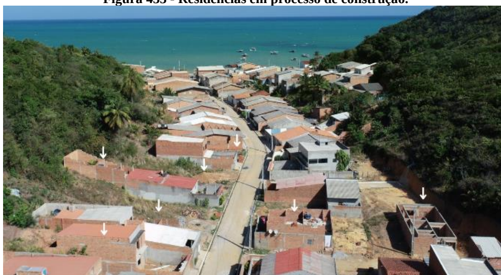
Figura 433 - Residências em processo de construção.
