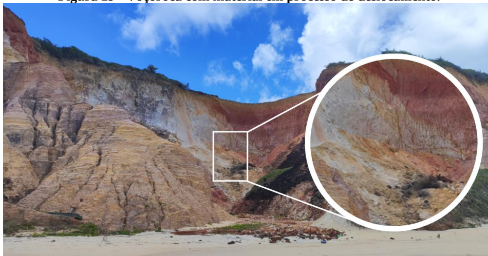
Figura 29 - Voçoroca com material em processo de deslocamento.
