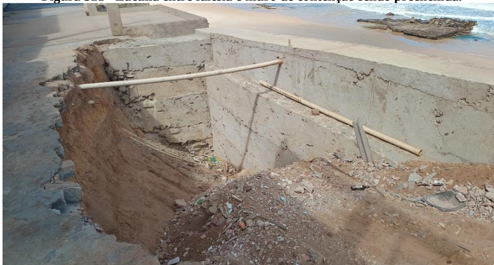
Figura 321 - Lacuna entre falésia e muro de contenção sendo preenchida.
